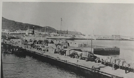
40. Las Palmas. Root of Inner breakwater
