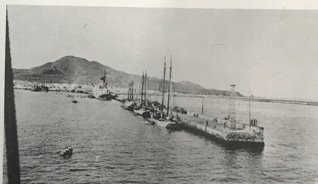
39. Las Palmas. Inner breakwater
