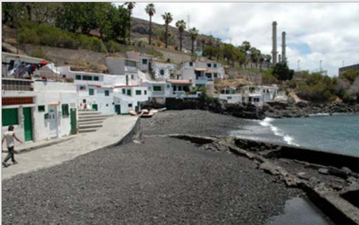
Foto: El Día( 2018.)Chovito antes de ser demolido.
