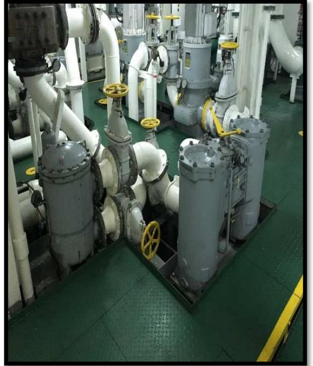
**Ilustración 44: Filtros de aceite (automático y dúplex).**
