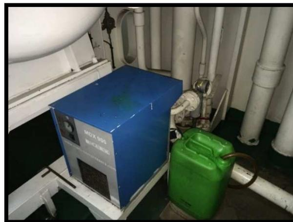
**Ilustración 71: Filtro secador de aire.**
