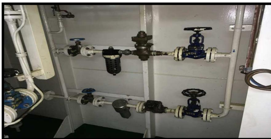
**Ilustración 72: Reductora de presión 30-7 bar.**
