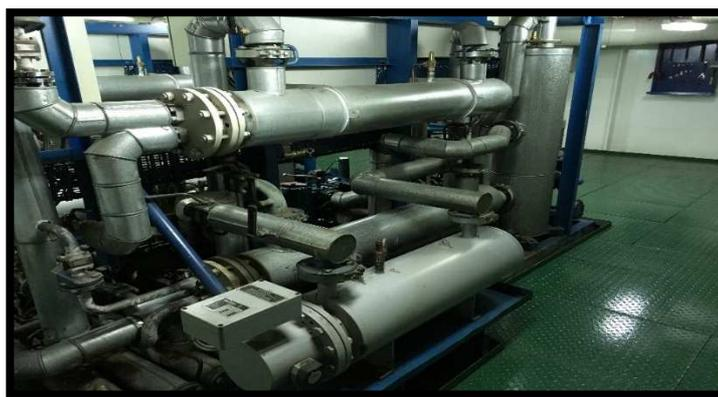
**Ilustración 27: Calentadores de módulos de combustible.**
