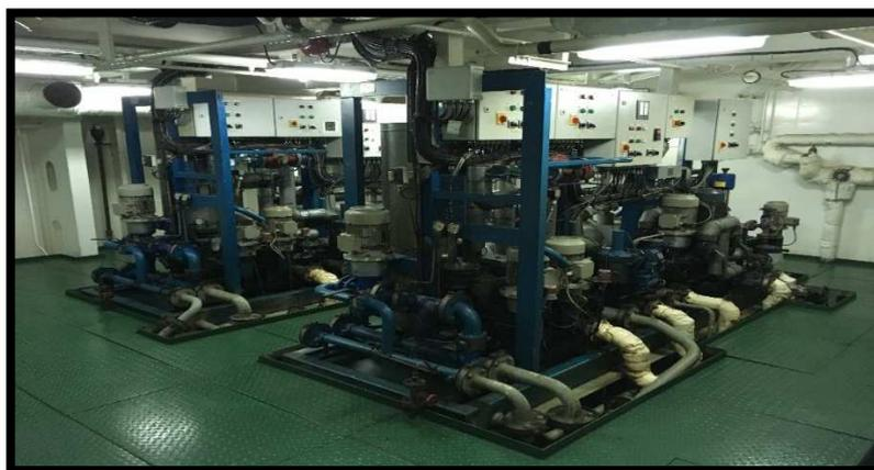
**Ilustración 25: Módulos de preparación de combustible.**
