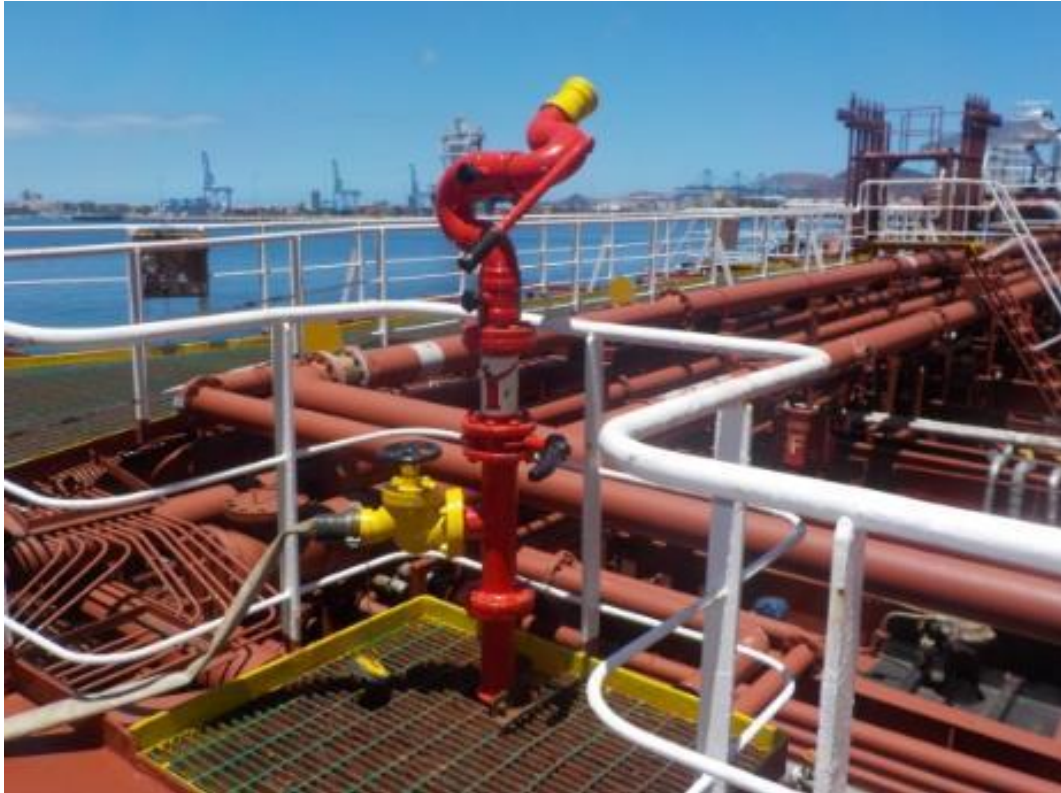
Ilustración 52. Líneas de salida a cubierta . Fuente: Trabajo de Campo.
