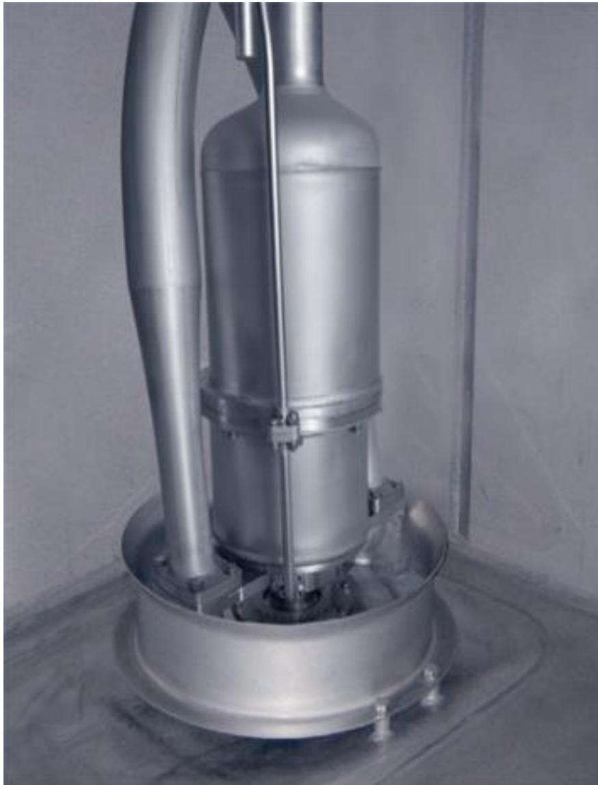
Ilustración 20. Bomba sumergida hidráulica. Fuente: Trabajo de Campo.
