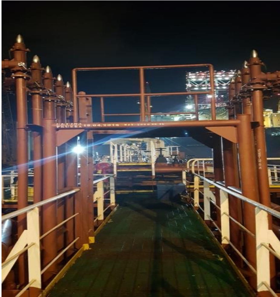
Ilustración 31. Valvulas p/v. Fuente: Trabajo de Campo.
