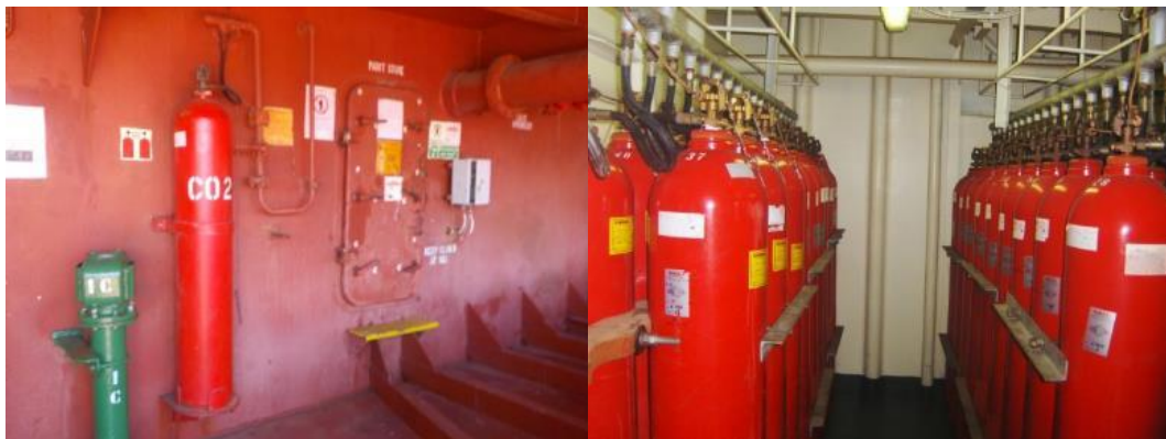
Ilustración 50 - (derecha) Local principal de CO 2 - (izquierda) Botella de CO 2 del pañol del proa. Fuente : Trabajo de Campo.
