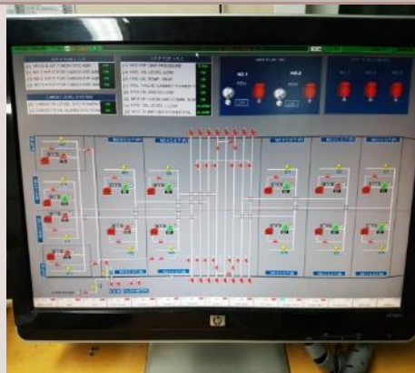
Panel de control de los parámetros referidos a los volúmenes de los tanques de carga.
