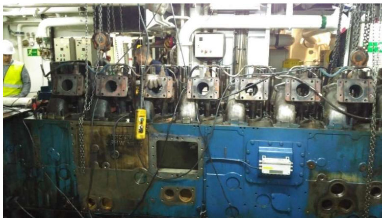
Ilustración 64. Bloque motor aligerado para el izado. Fuente: Trabajo de campo,
