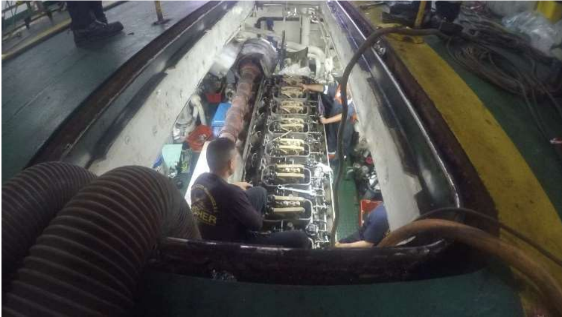
Ilustración 49. Vista desde la lumbra del motor en la cubierta principal del montaje del motor. Fuente: Trabajo de campo.
