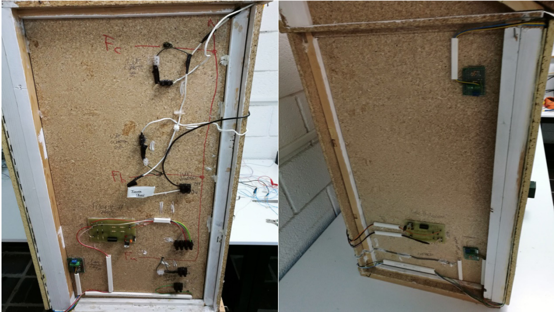
Figura 4.61. Cableado y circuitos en los laterales izquierdo y derecho de la maqueta
