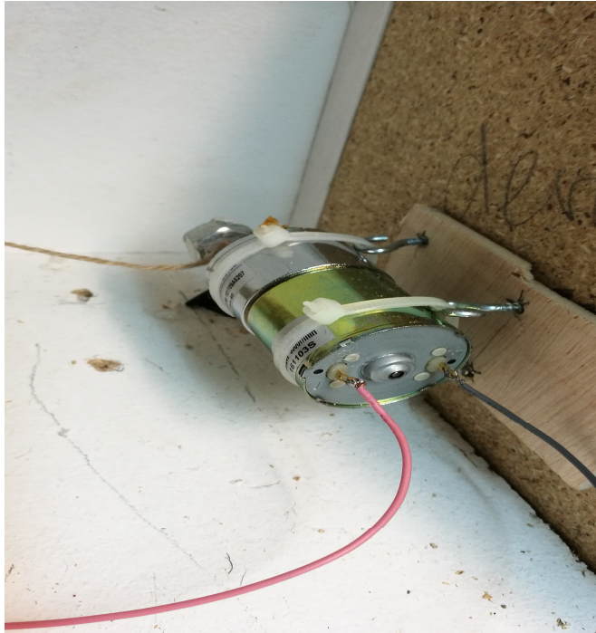
Figura 4.52. Motor del ascensor
