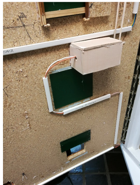
Figura 5.6. Estructura de enrollado de las persianas (izquierda) y motor que controla su movimiento (derecha) ocultos.
