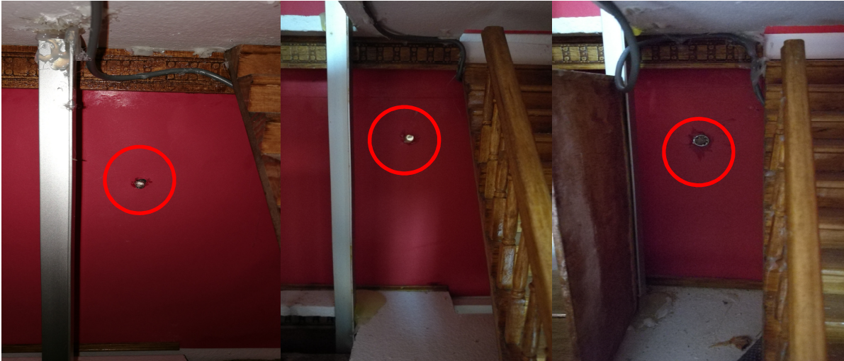
Figura 4.54. Luces automáticas en los rellanos
