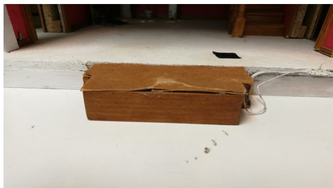
Figura 4.23. Localización del pulsador en la entrada principal
