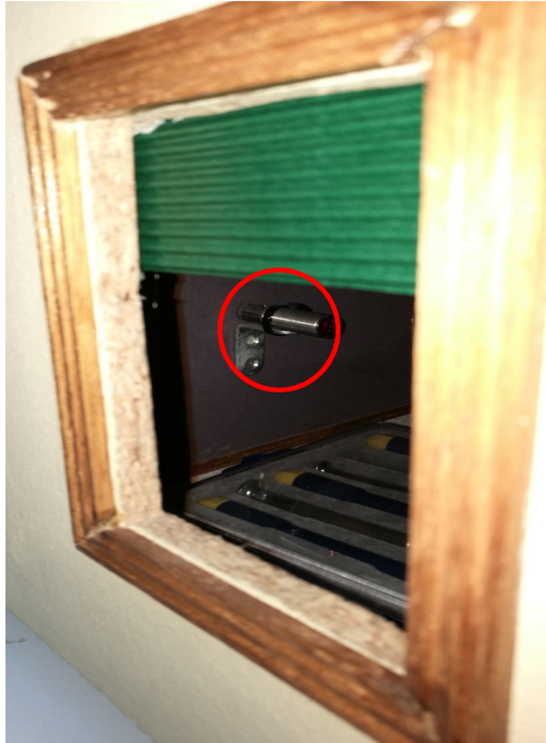
Figura 4.46. Detección de intrusos en primera planta
