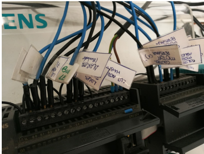
Figura 4.63. Etiquetado de las conexiones
