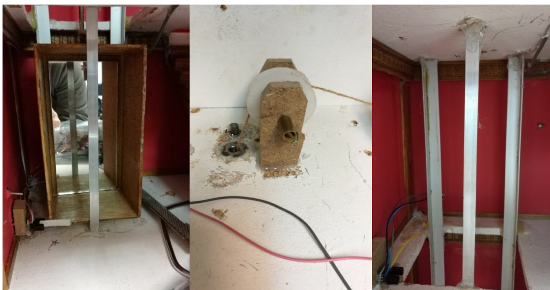
Figura 5.9. Estructura del ascensor en el nuevo montaje
