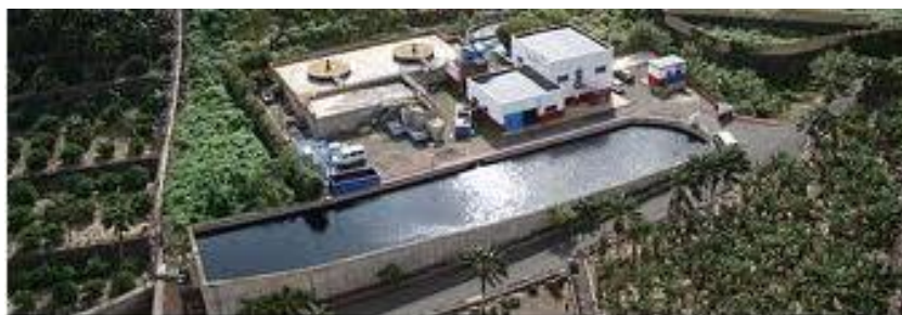
Figura 21. Imagen de la Estación de Depuración de Aguas Residuales situada en Valle Guerra, Tenerife (Europe, 2013).
