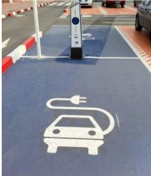
Figura 9. Señalización de plaza reservada para la recarga de VE.
