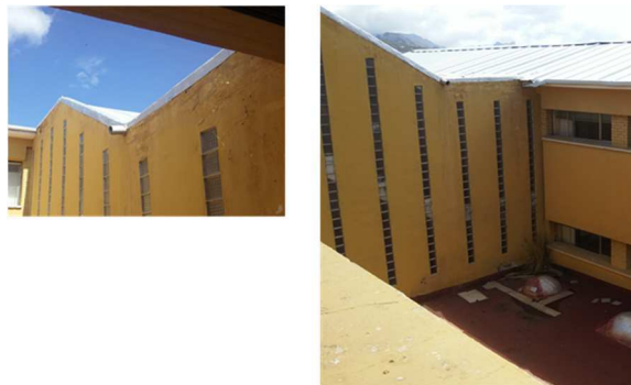
Figura 5. Vista parcial estado actual de las cubiertas, Fuente: Elaboración propia
