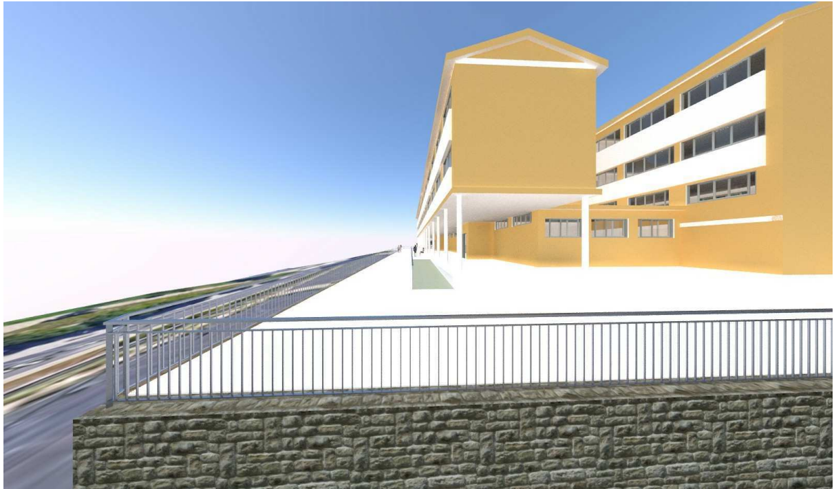
Fig. 24. Vista parcial fachada Norte y Este obtenida con EDIFICIUS. Estado actual. Fuente: Elaboración propia.
