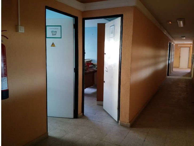
Figura 4. Vista parcial entreplanta segunda (estado actual), Fuente: Elaboración propia
