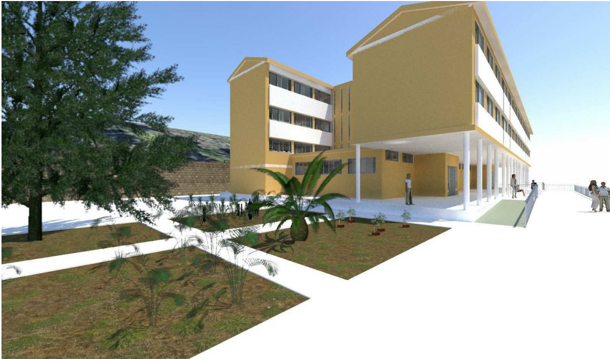
Fig.22. Vista Fachada Sur y Este obtenida con EDIFICIUS. Estado actual. Fuente: Elaboración propia.
