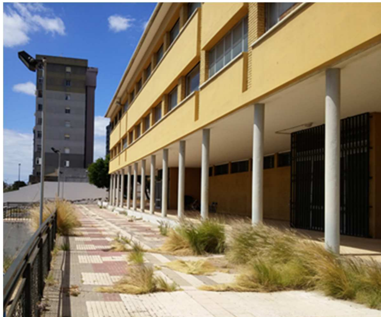
Figura 2. Fachada Este del Edificio, Fuente: Elaboración propia
