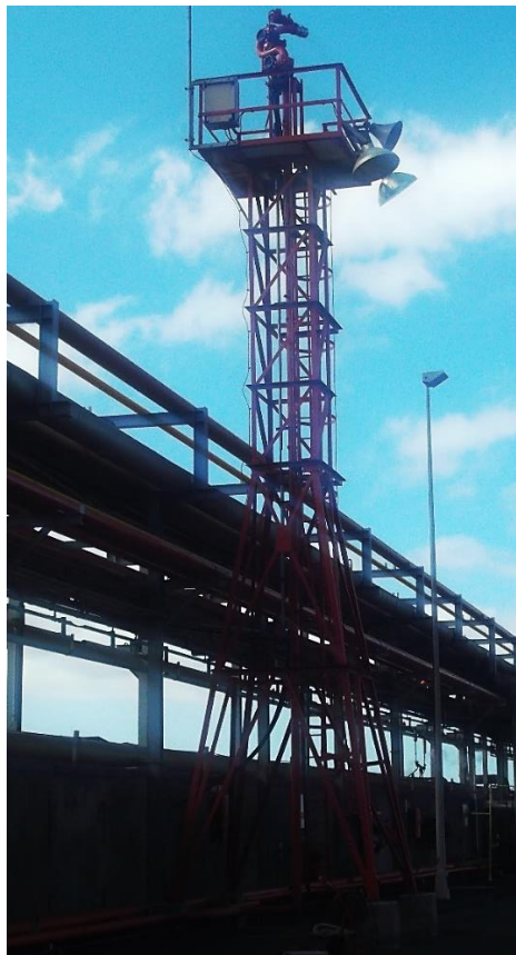
Figura 14. Torre Monitora en Muelle Ciego. Fuente: Propia.
