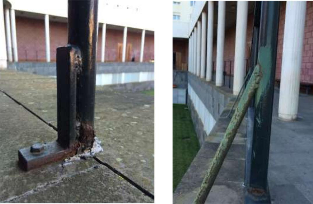
Figura 3 y Figura 4. Soportes de refuerzo de distinto material respecto a la barandilla situada en la facultad Física y Matemáticas ULL. Fuente: Propia.
