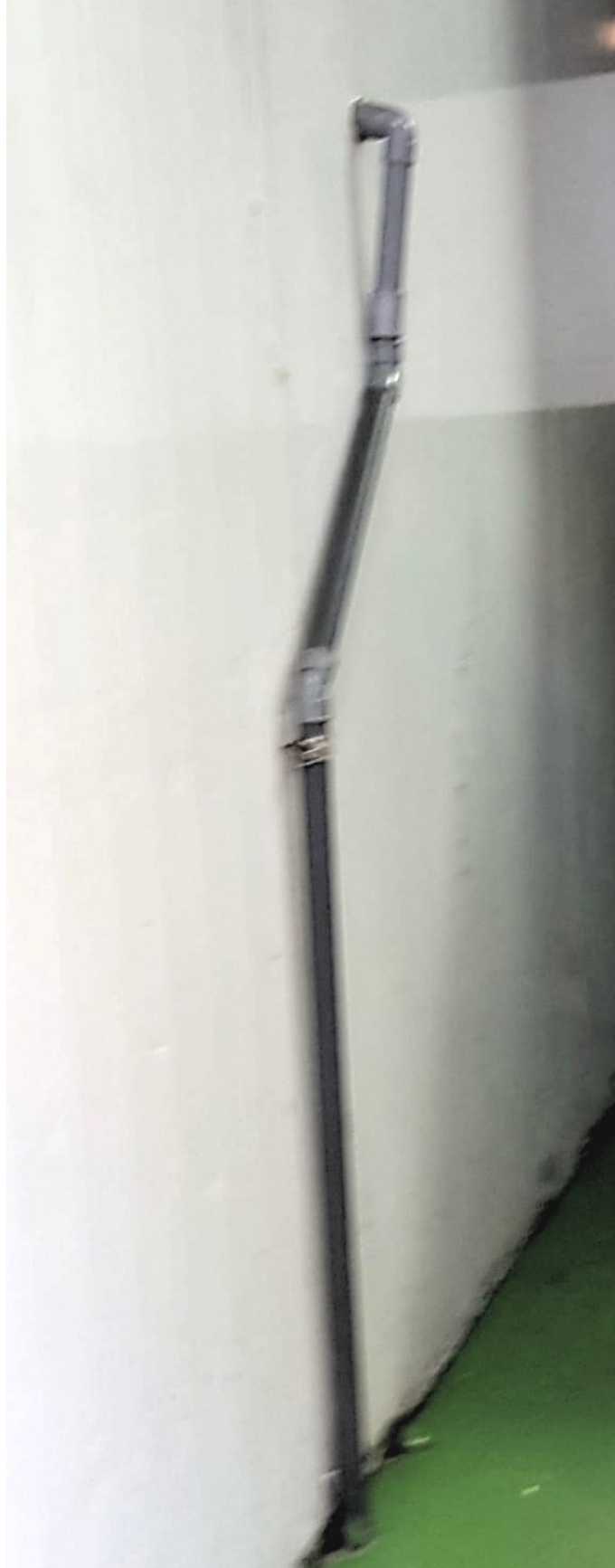
Figura A.5: Tubo de salida del agua de desescarche (entre 2 y 5 °C)
