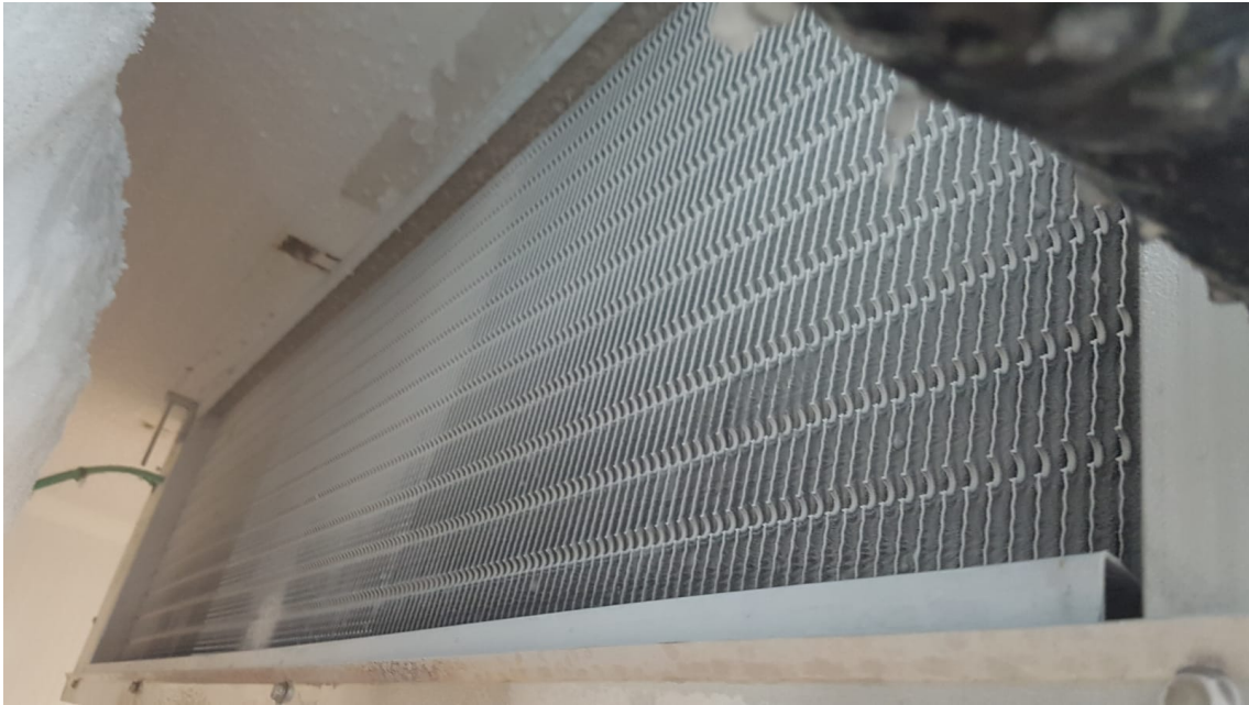
Figura A.2: Parte trasera evaporador FRIMETAL FRB-790-E Fuente: Elaboración propia
