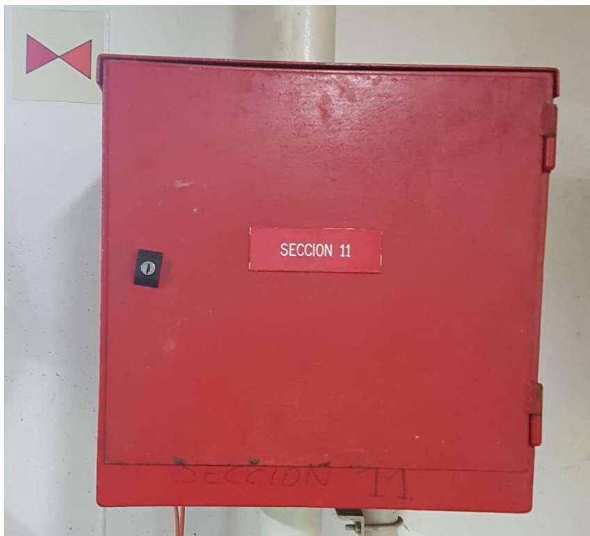
Ilustración 8. Caja de sección de Sprinkler. Fuente Propia.
