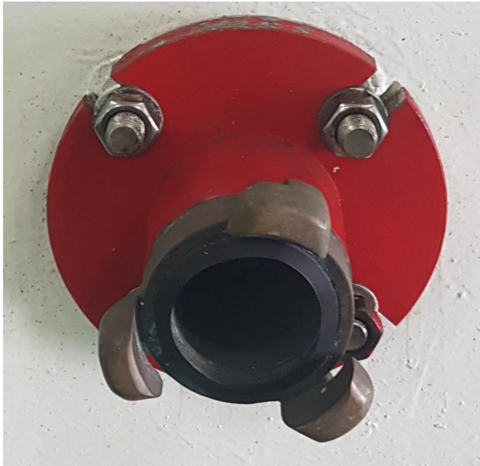
Ilustración 17. Conexión Internacional a Tierra. Fuente Propia.
