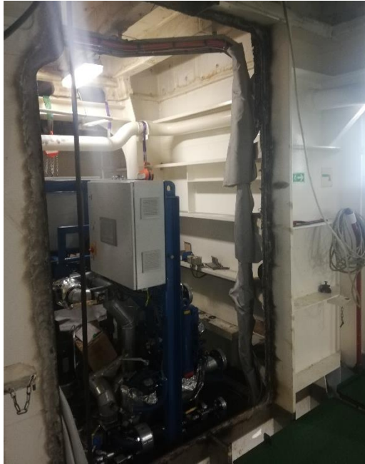
Ilustración 1: Instalación de un nuevo módulo de combustible
