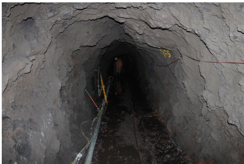
Figura 6. Galería en fase de reperfóraci3n para aumentar los caudales. Fuente: Santamarta J.C.
