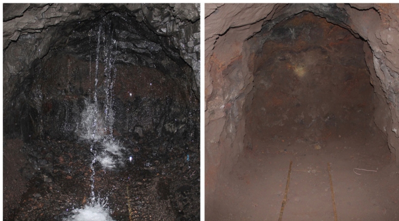
Figura 5. Frentes de galería con agua (izq.) y seca (der.). Fuente: Santamarta J.C.
