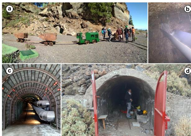
Figura 4.1: Sistema de transporte por vagonetas (a) y alumbramiento de agua (b) en la galería Vergara, Tenerife. Interior de la galería La Fuente Santa en Fuencaliente, La Palma (c). Vista de la bocamina de la galería Río de Guía en Tenerife (d).
