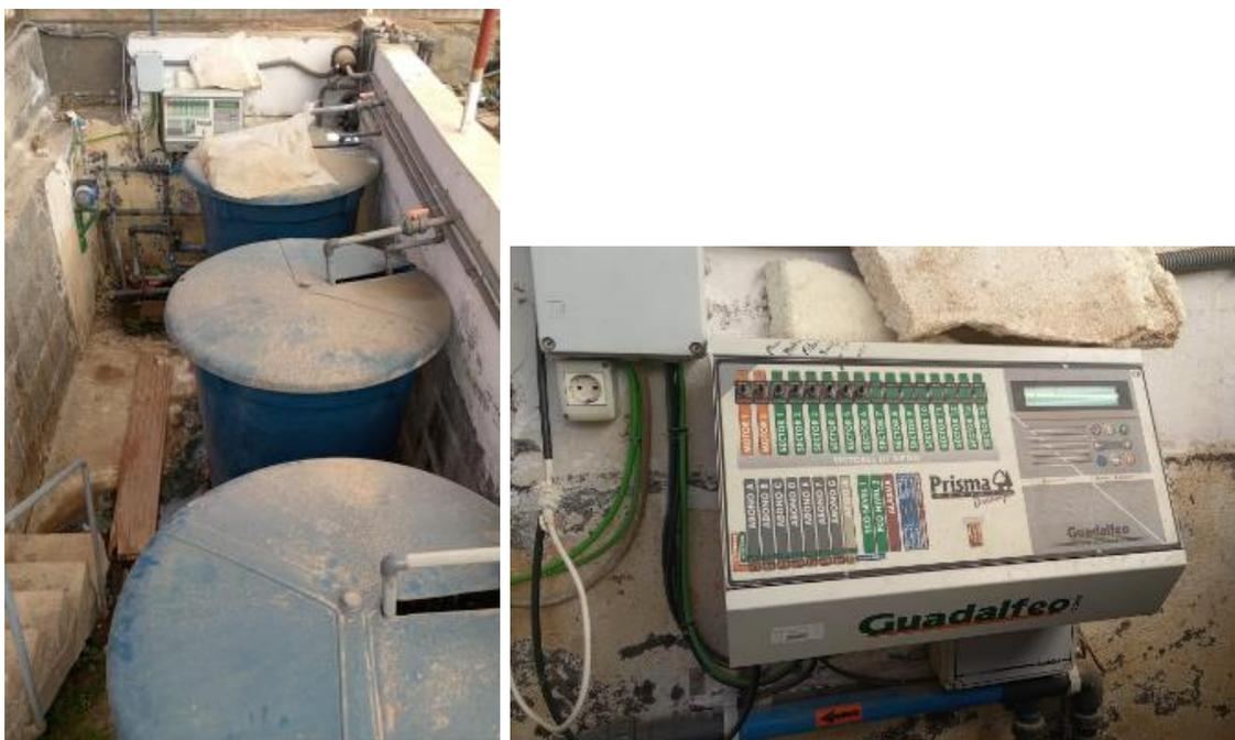
Foto 1: Tanques de abonado y programador de riego
