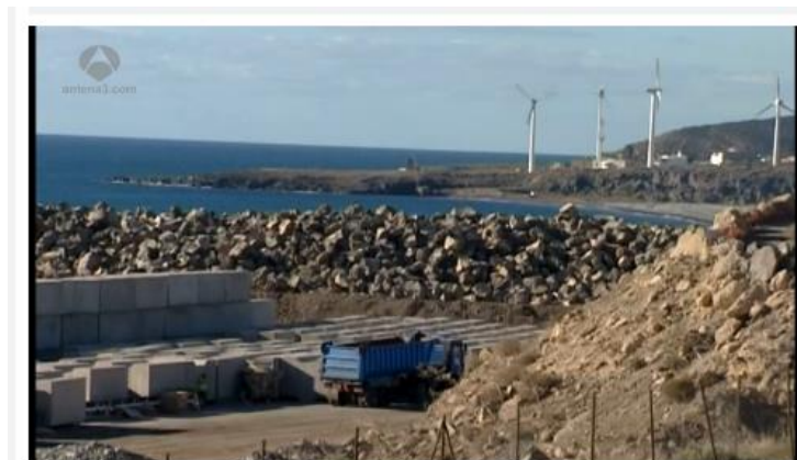
Anexo 26. Construcción de un nuevo centro de reciclaje en el polígono industrial de Granadilla.
