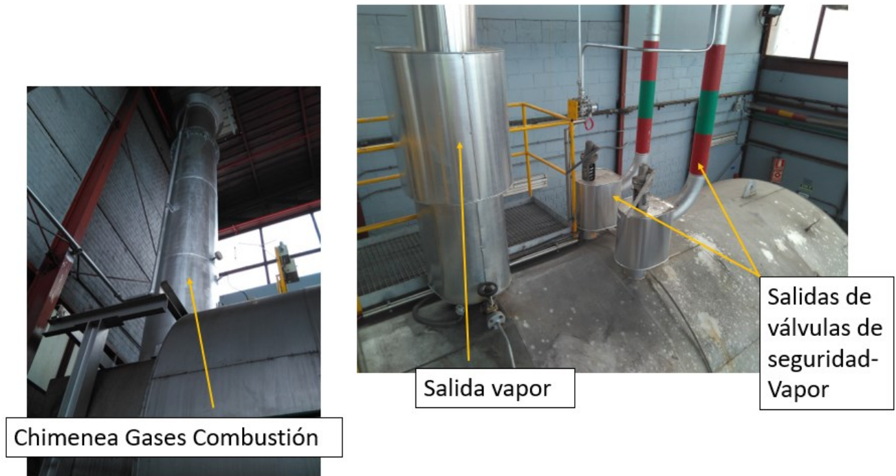
Ilustración 6. Principales Salidas de la Caldera. Fuente: Elaboración propia
