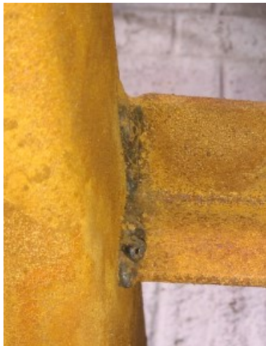
Ilustración 10. Soldadura estructura propano. Fuente: Elaboración propia
