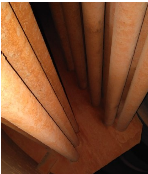
Ilustración 14. Haces de tubo interior caldera. Fuente: Elaboración propi
