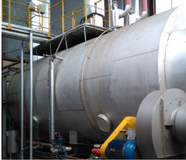
Ilustración 12. Pared lateral caldera. Fuente: Elaboración propia
