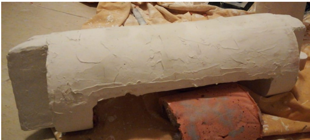
Ilustración 18. Poliuretano completamente cubierto de macilla. Fuente: Elaboración propia.
