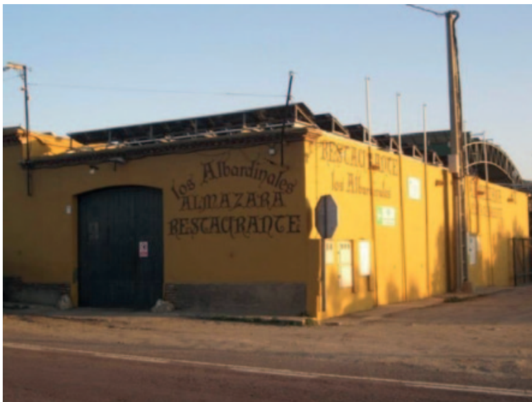
Figura 6: Vista exterior del inmueble en la actualidad.
