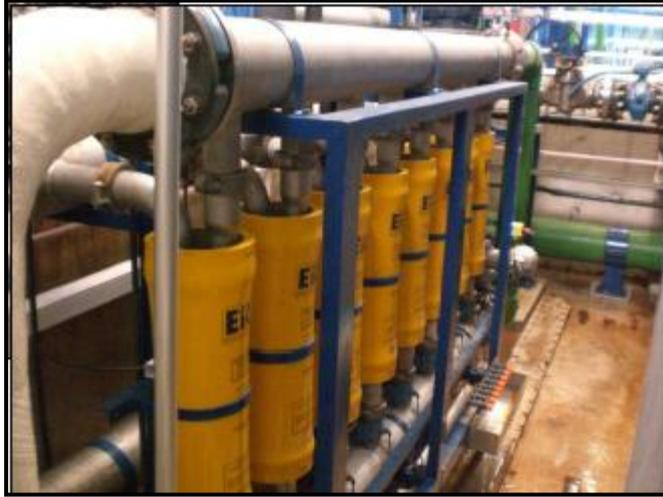
**Figura A2. 6 Instalación Intercambiadores de presión PX**
