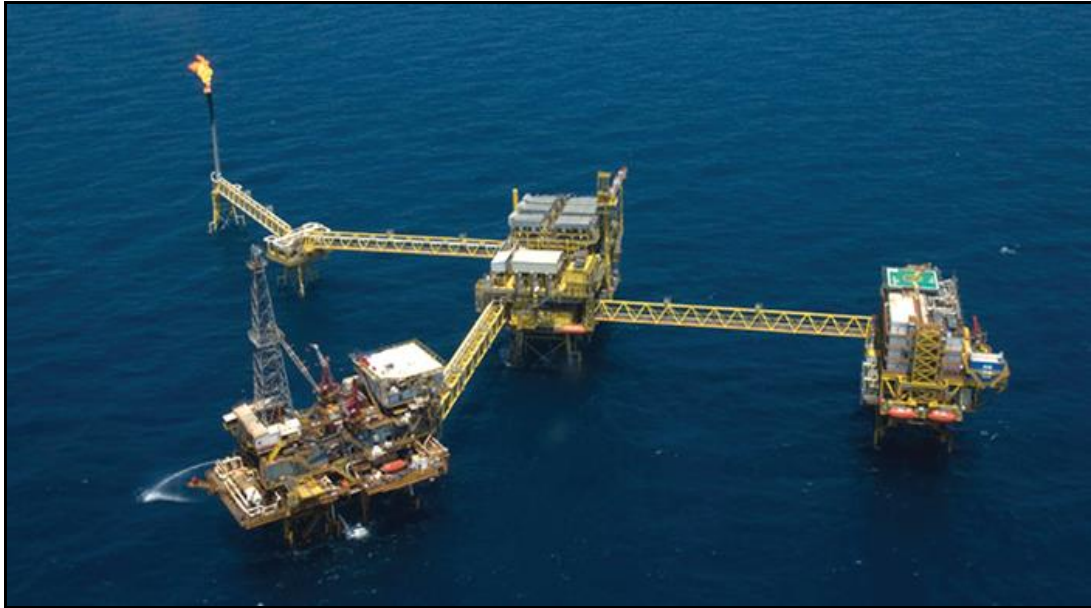
Complejo de plataformas fijas
