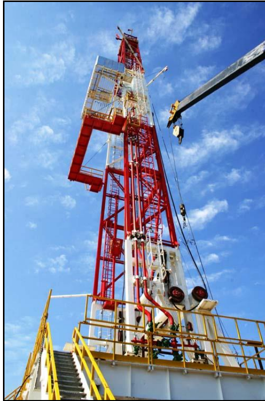
Torre o mástil
