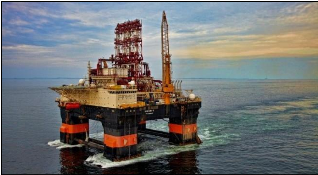
Plataforma semisumergible Scarabeo-9
