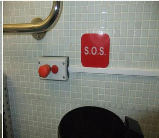
Figura 14: Pulsador de emergencia a baja altura y con señalización. Fuente: Elaboración propia.
