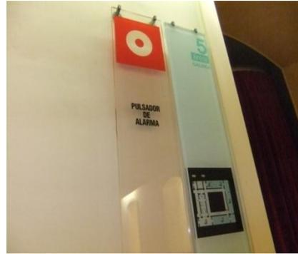
Figura 17: Pulsador de alarma visible y accesible. Fuente: Elaboración propia.
