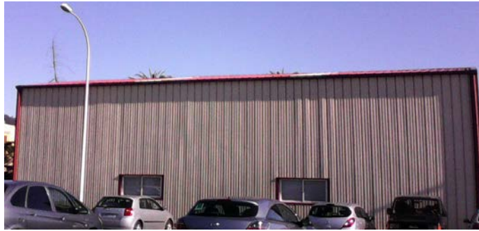
Fig. 1.12. Vista del exterior de la nave 2.
