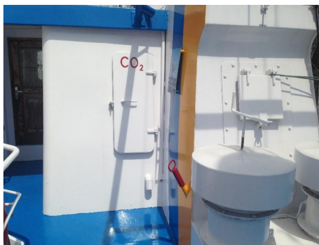
Ilustración 106. Vista alejada de la ubicación de la llave de corte de combustible en caso de emergencia. Fuente: elaboración propia.
