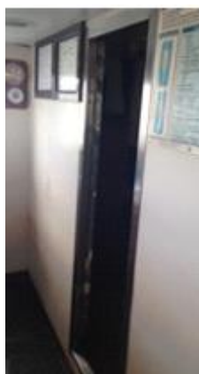
Ilustración 62. Puerta del camarote situado en el puente. Fuente: elaboración propia.
