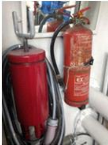
Ilustración 94. Boca y manguera contra incendios en la entrada de la sala de máquinas y extintor de polvo del tipo A, B y C ubicado en la parte delantera del motor principal. Fuente: elaboración propia.
