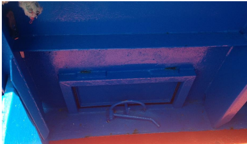
Ilustración 30. Portón/imbornal en la amurada para evacuar el agua que entra al buque. Fuente: elaboración propia.
