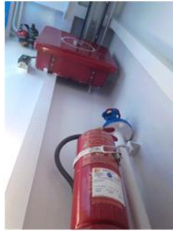
Ilustración 94. Boca y manguera contra incendios en la entrada de la sala de máquinas y extintor de polvo del tipo A, B y C ubicado en la parte delantera del motor principal. Fuente: elaboración propia.
