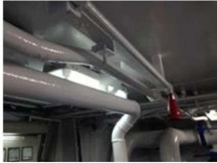
Ilustración 93. Rociador del sistema de CO2 de la sala de máquinas y su alarma correspondiente. Fuente: elaboración propia.
