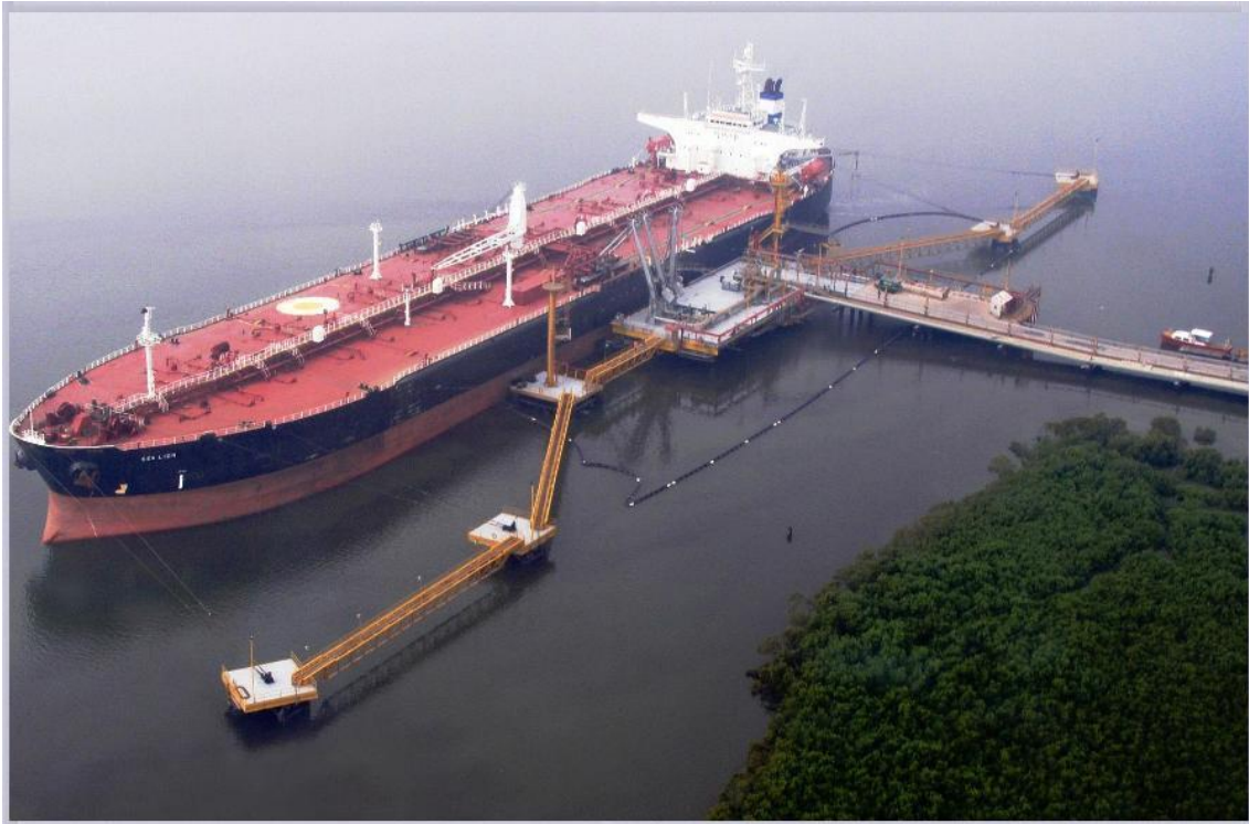
Ilustración 54. Buque petrolero atracado en un cargadero y amarrado a duques de alba. Fuente: Khan, S. (2011). Shipping activity at port Qasim [Fotografía].
