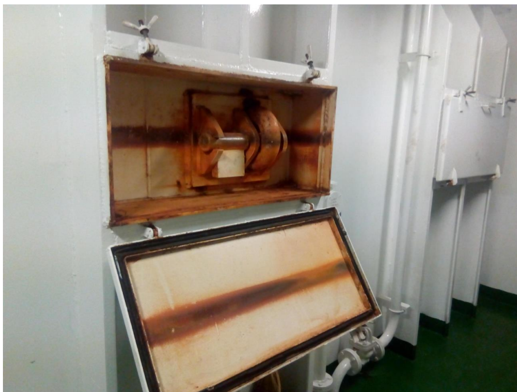
Ilustración 3. Malla accesible desde el exterior de la caja de cadenas.
