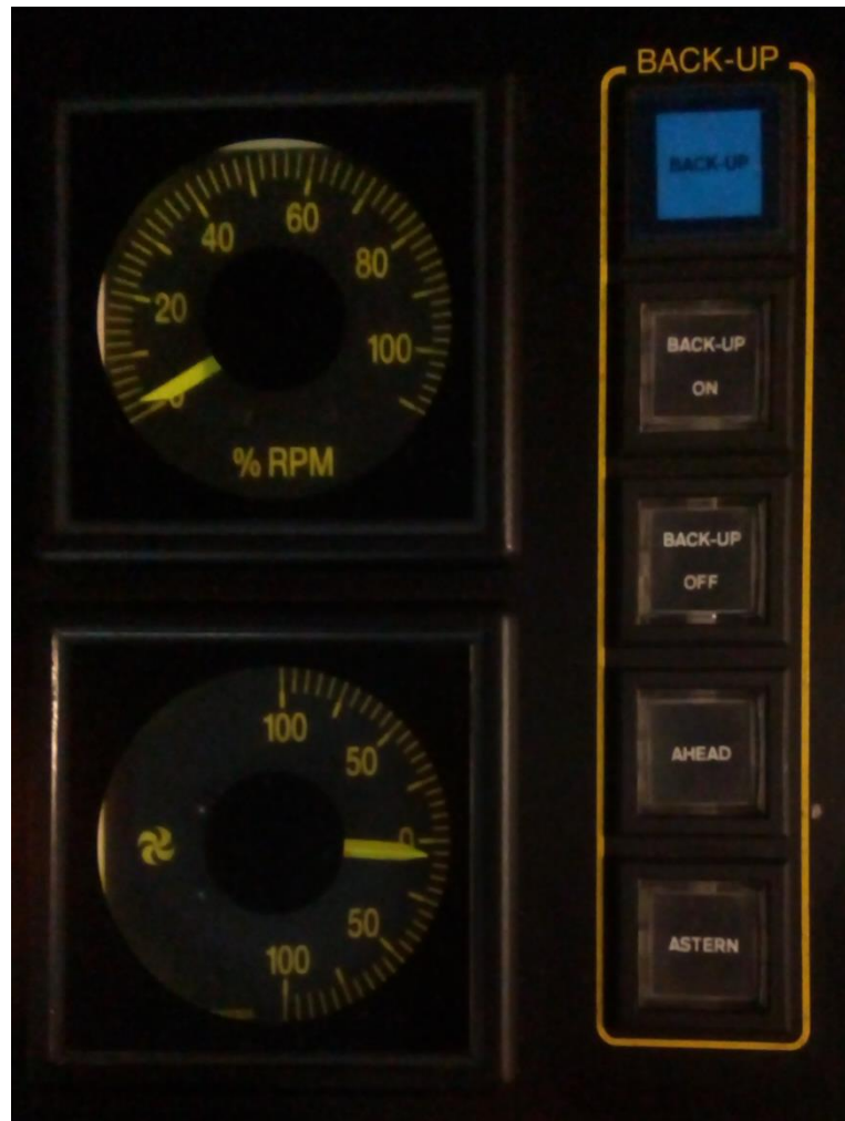
Ilustración 37. Sistema de emergencia Back-up de control de paso de la hélice.
