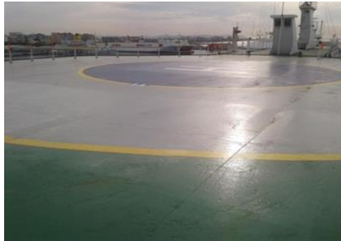
Imagen 25. Helipuerto. Fuente: Trabajo de campo.
