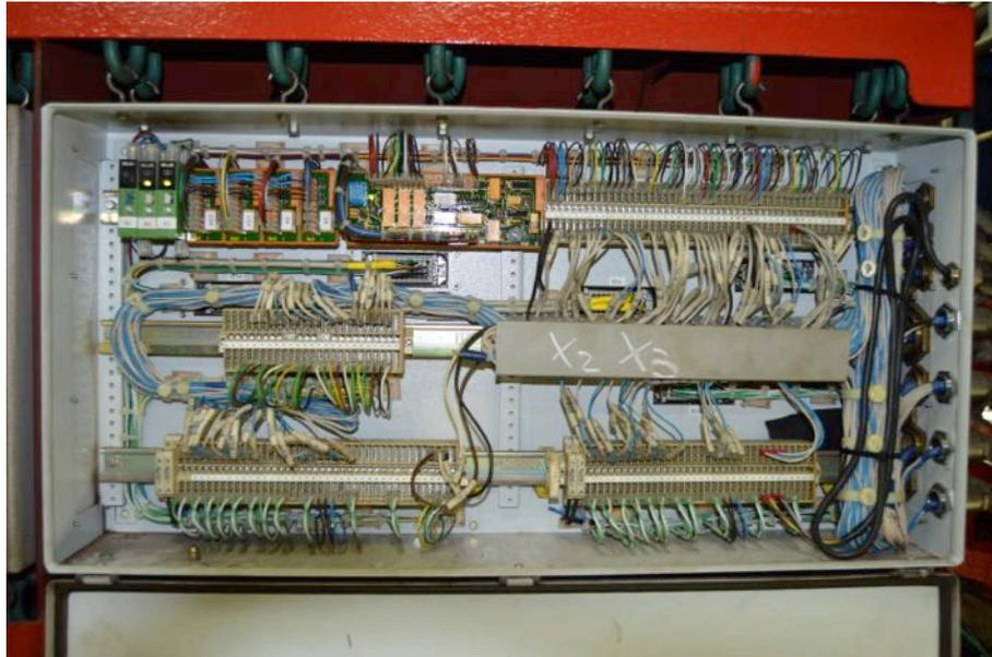
**Figura 5.3:** Vista de la caja de conexiones B (X2, X3) de los sensores del motor.
