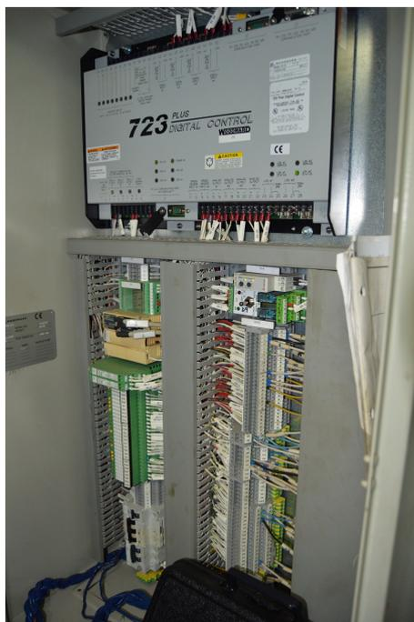
**Figura 1.1:** Módulo de conexiones de las tarjetas de control y cuadro de gobierno de velocidad.
