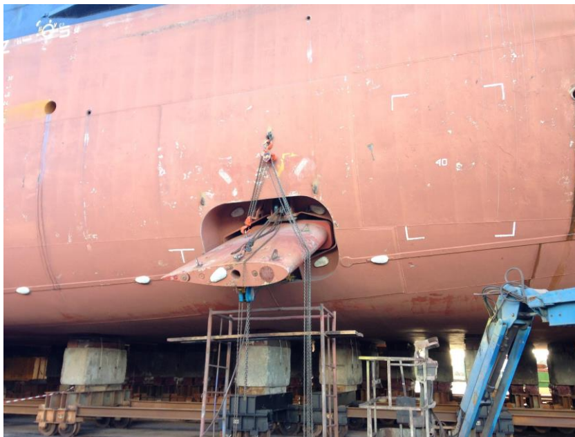
Ilustración 39: Ocean Endeavour, reparación del estabilizador de estribor
