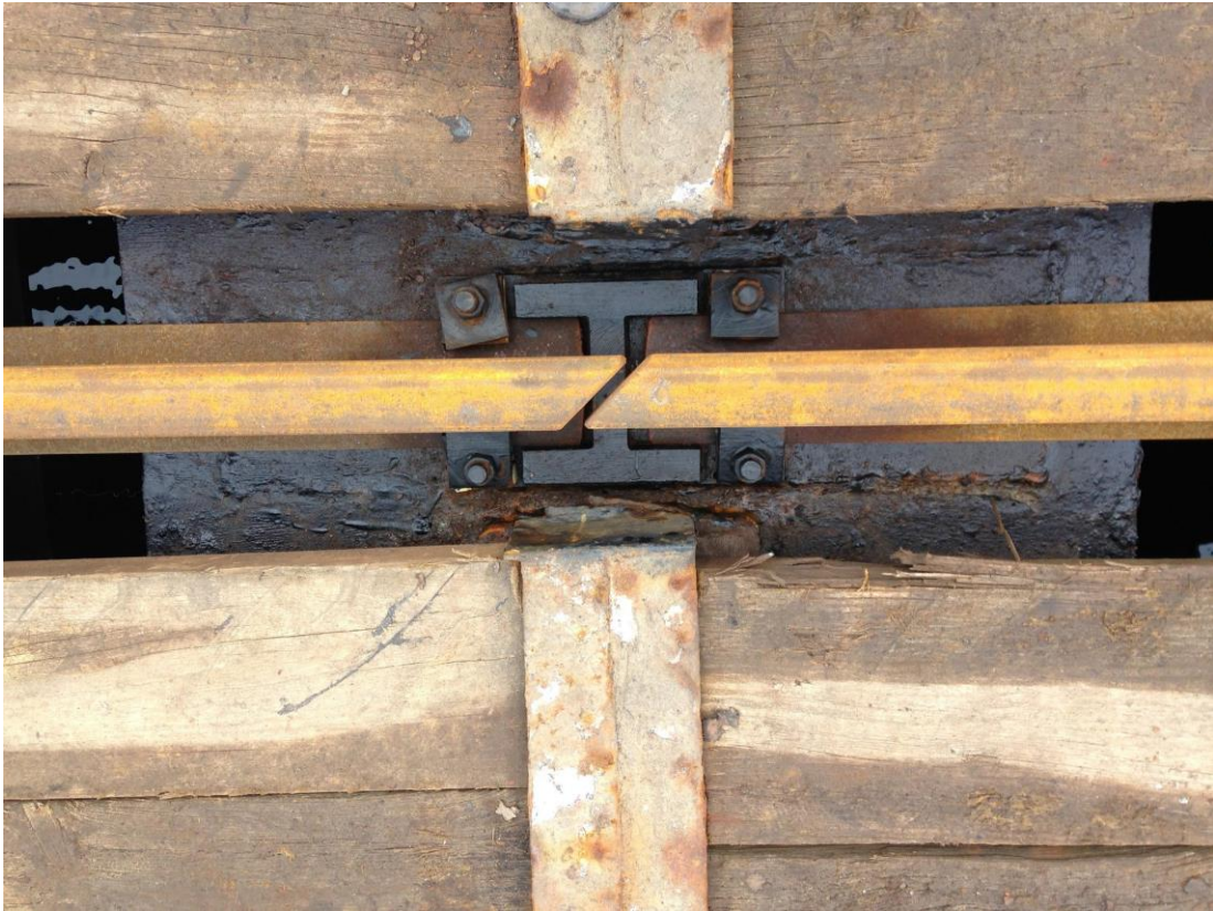
Ilustración 12: Unión de raíles
