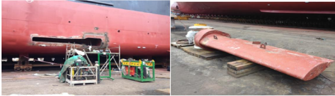
Ilustración 41: Silver Explorer, reparación del estabilizador de babor
