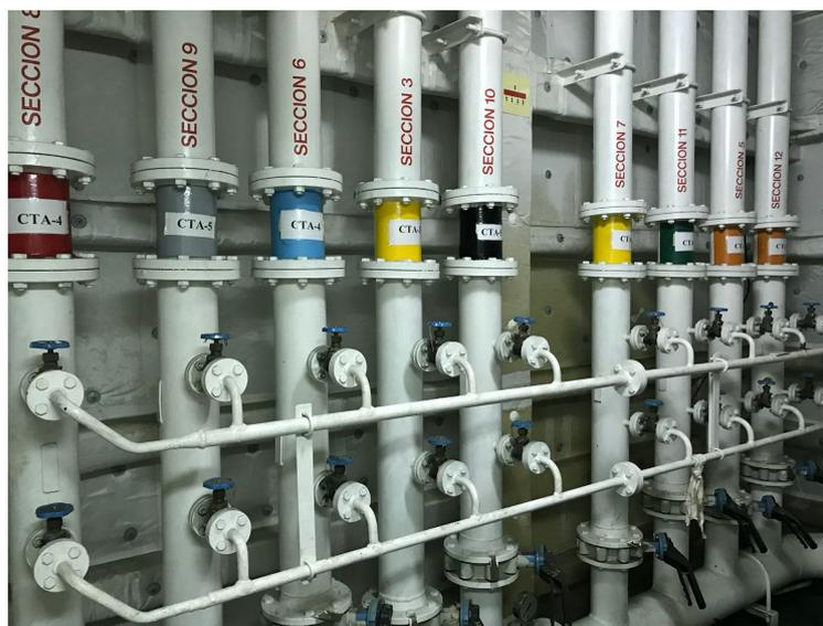
*Ilustración 17. Válvulas de disparo de rociadores. Fuente: Trabajo de campo*
