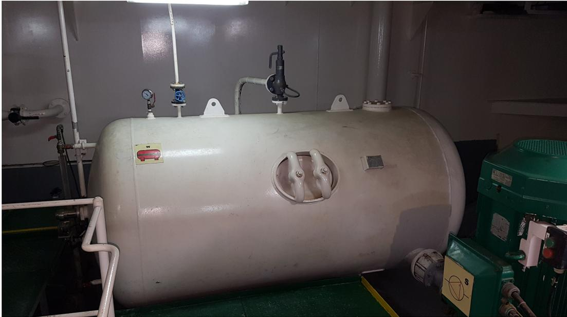
*Ilustración 6. Tanque de Sprinkler. Fuente: Trabajo de campo*
