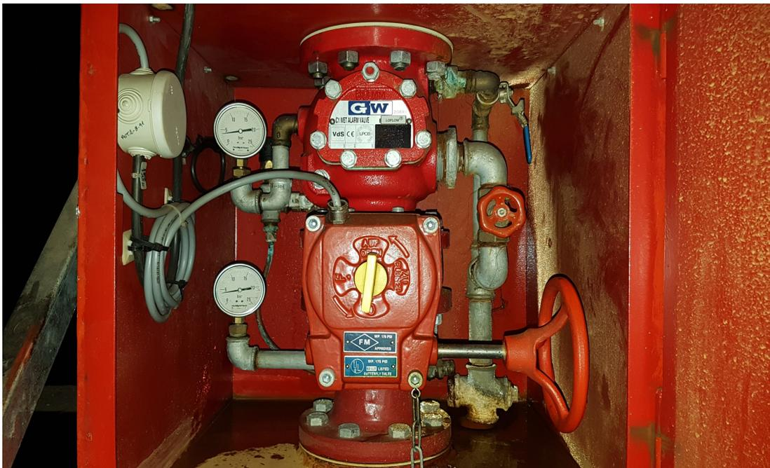
*Ilustración 5. Sección de Sprinkler. Fuente: Trabajo de campo*
