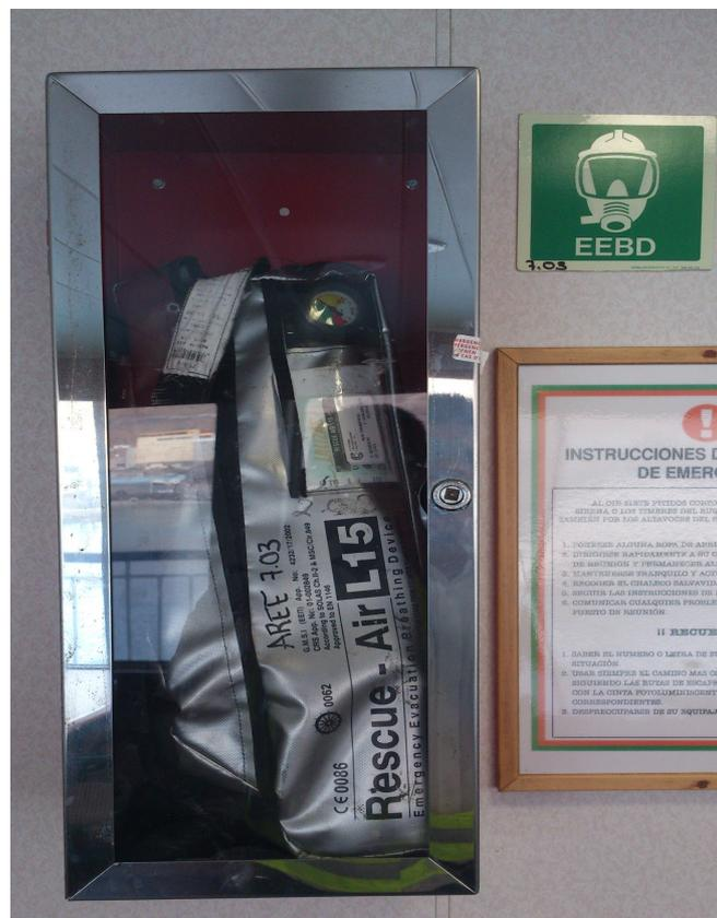
Ilustración 55. Equipo AREE estibado. Fuente: Trabajo de campo
