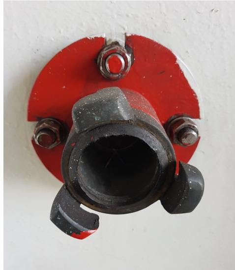
*Ilustración 25. Conexión a tierra internacional. Fuente: Trabajo de campo*
