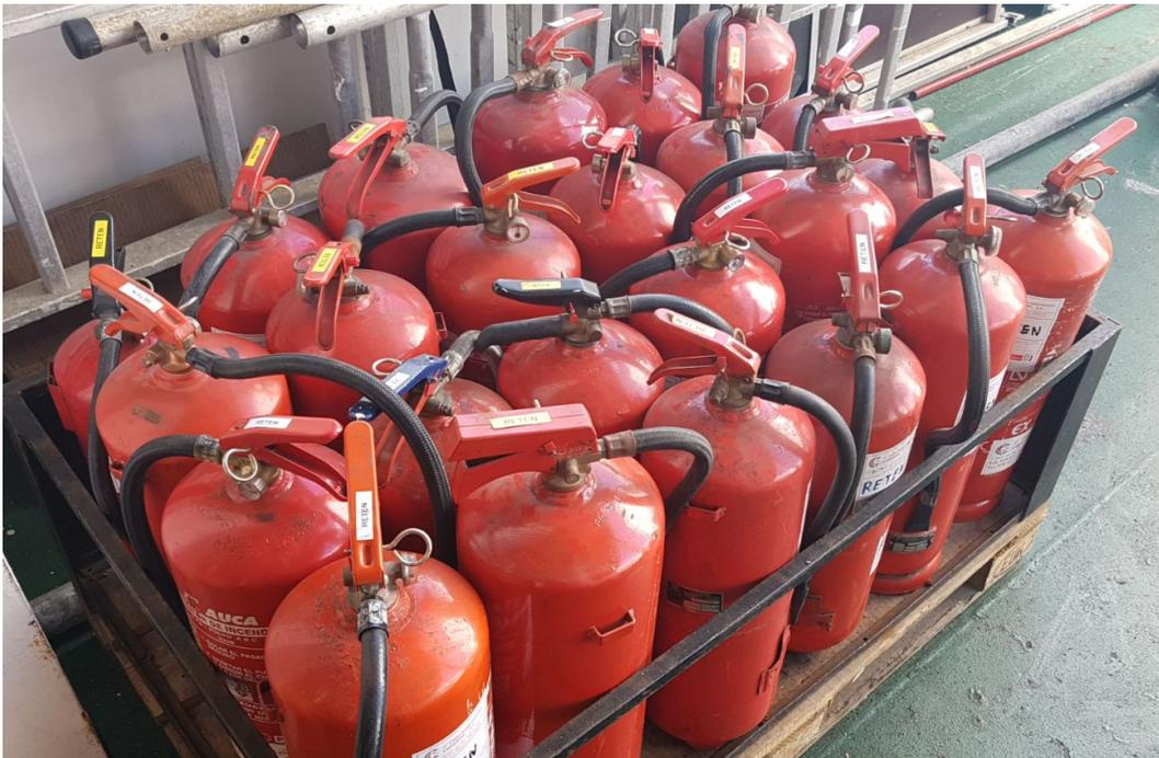
*Ilustración 34. Extintores de polvo A,B,C.. Fuente: Trabajo de campo*
