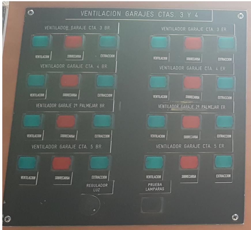
Ilustración 49. Panel de ventilación de garajes en el puente de mando. Fuente: Trabajo de campo
