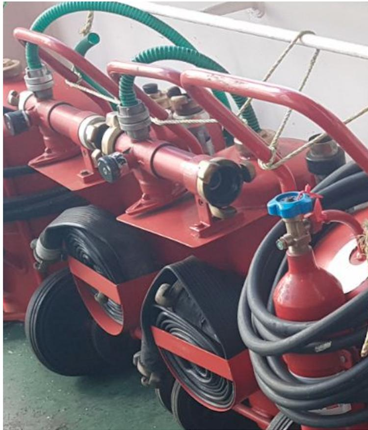
*Ilustración 36. Dispositivos portátiles de espuma. Fuente: Trabajo de campo*
