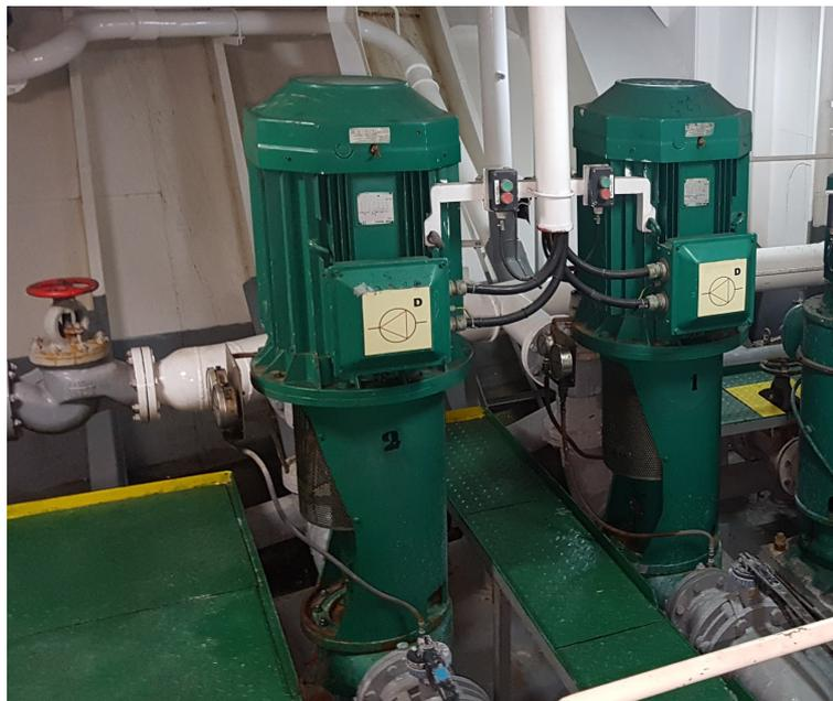
*Ilustración 16. Bombas sistema de rociadores de garaje. Fuente: Trabajo de campo*
