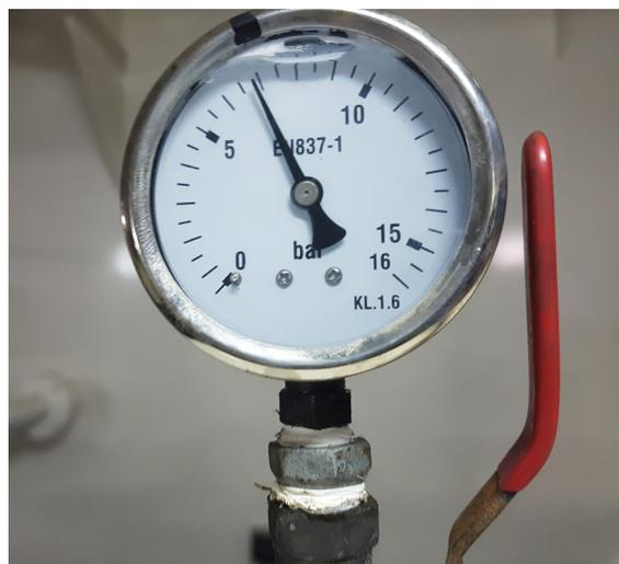
Ilustración 8. Manómetro del tanque de Sprinkler. Fuente: Trabajo de campo
