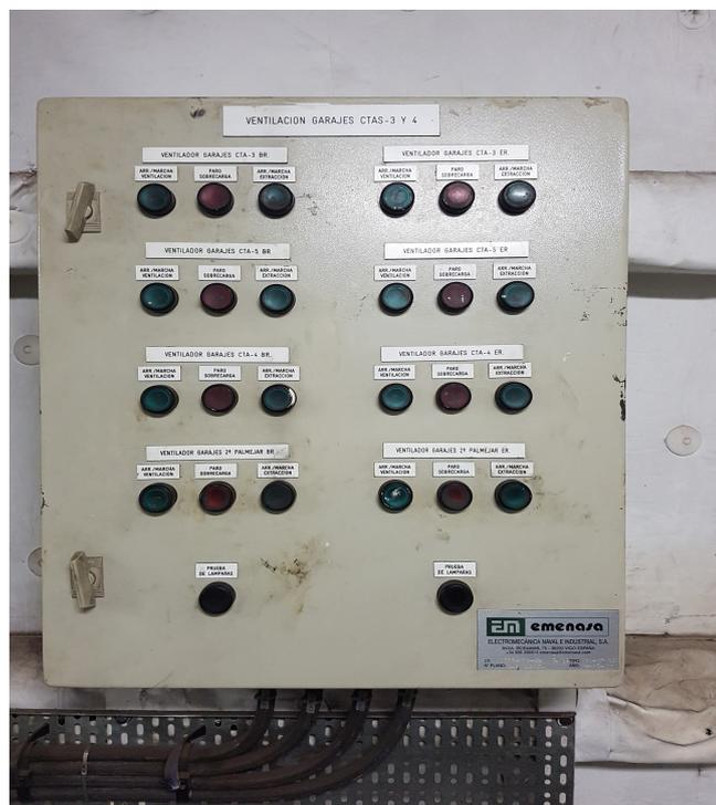
Ilustración 50. Panel de ventilación de garaje. Fuente: Trabajo de campo
