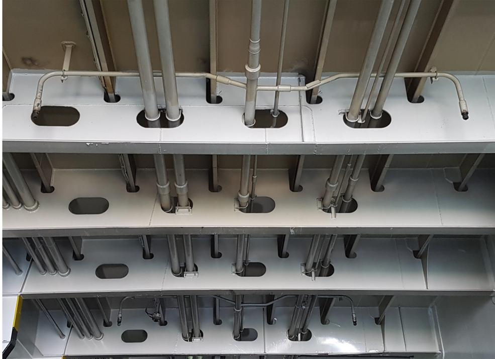
*Ilustración 12. Boquillas de rociadores de garaje. Fuente: Trabajo de campo*
