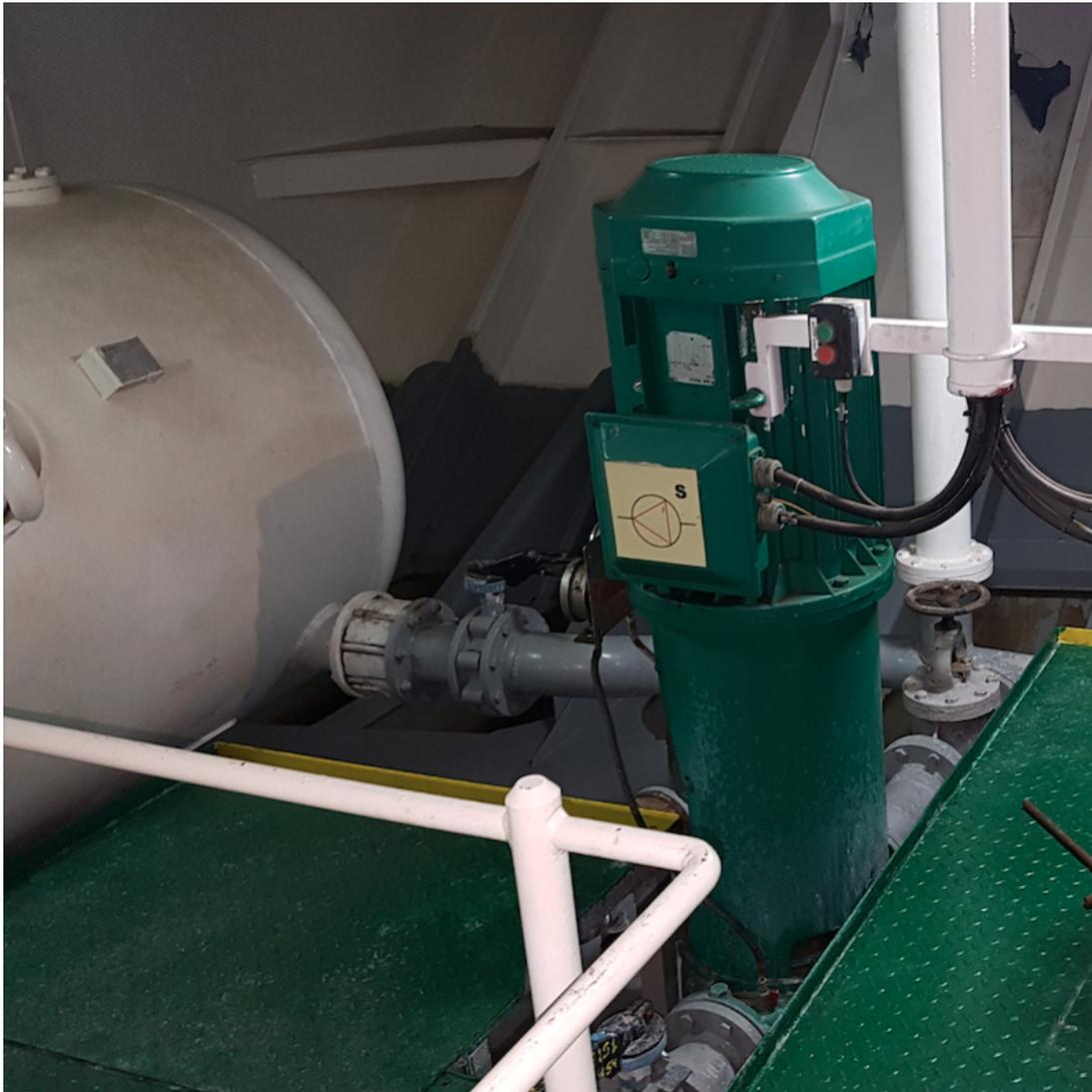
*Ilustración 10. Bomba de Sprinkler. Fuente: Trabajo de campo*
