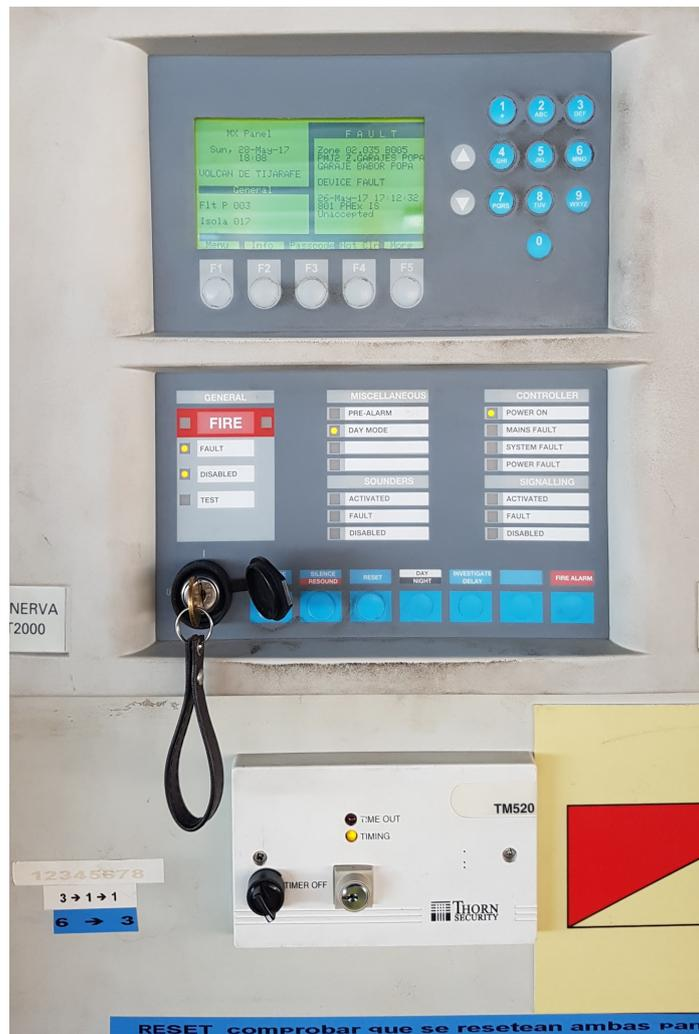
Ilustración 28. Central controladora Minerva T2000. Fuente: Trabajo de campo
