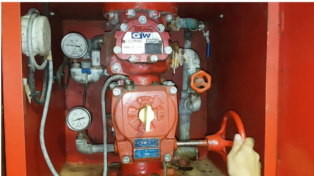
*Ilustración 11. Manipulación de una sección de Sprinkler. Fuente: Trabajo de campo*
