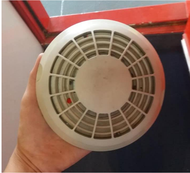
Ilustración 40: Detector Humo. Fuente: Trabajo de Campo.
