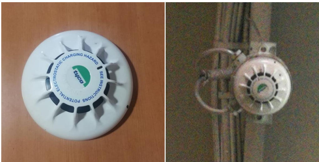
Ilustración 8. Detector antideflagrante. Fuente propia.
