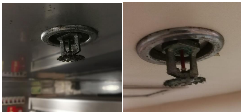
Ilustración 34. Sprinkler verde (93°) y rojo (68°). Fuente propia.
