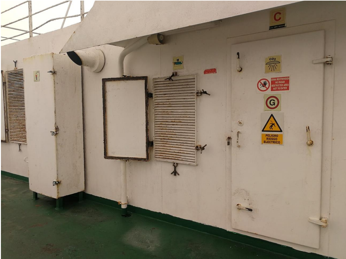
Ilustración 60. Entrada al Local del generador de emergencia. Fuente propia.
