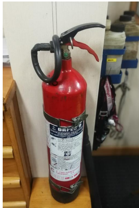
Ilustración 27. Extintor portátil de CO 2 . Fuente propia
