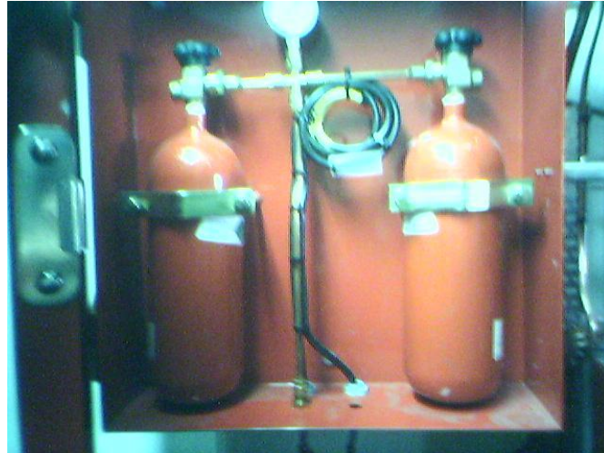
Ilustración 56. Armario disparador del CO 2 . Fuente: Manual de formación Naviera Armas.
