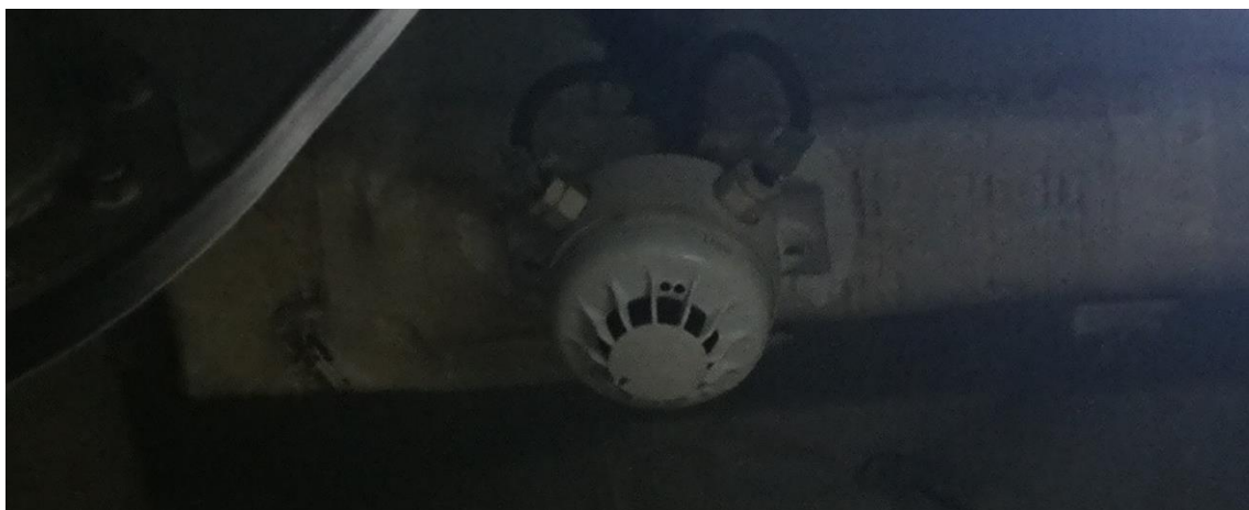
Ilustración 6. Detector de humo de la máquina. Fuente propia.
