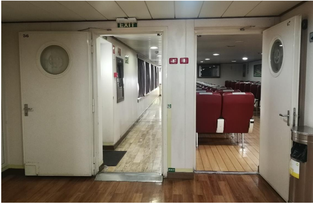
Ilustración 89. Puertas contra incendios zona de habitación. Fuente propia.
