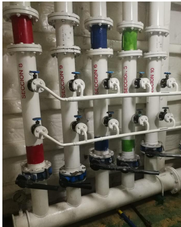
Ilustración 47. Local de rociadores de garaje. Fuente propia.
