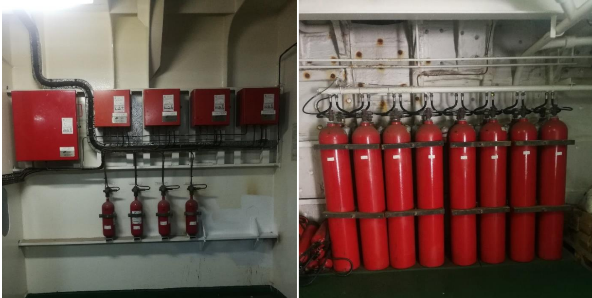
Ilustración 53. Local de CO 2 de la máquina. Fuente propia.
