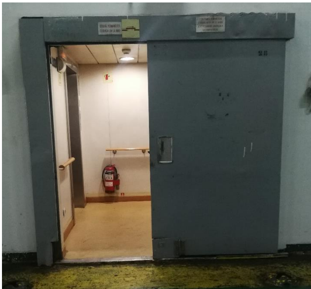
Ilustración 90. Puerta contra incendios zona de carga. Fuente propia.
