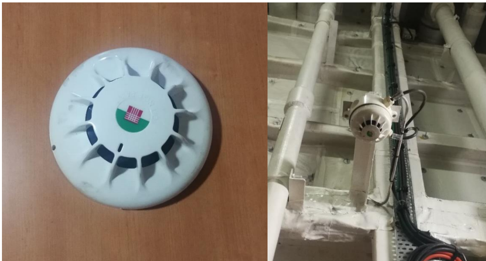
Ilustración 5. Detector de humo y temperatura. Fuente propia.
