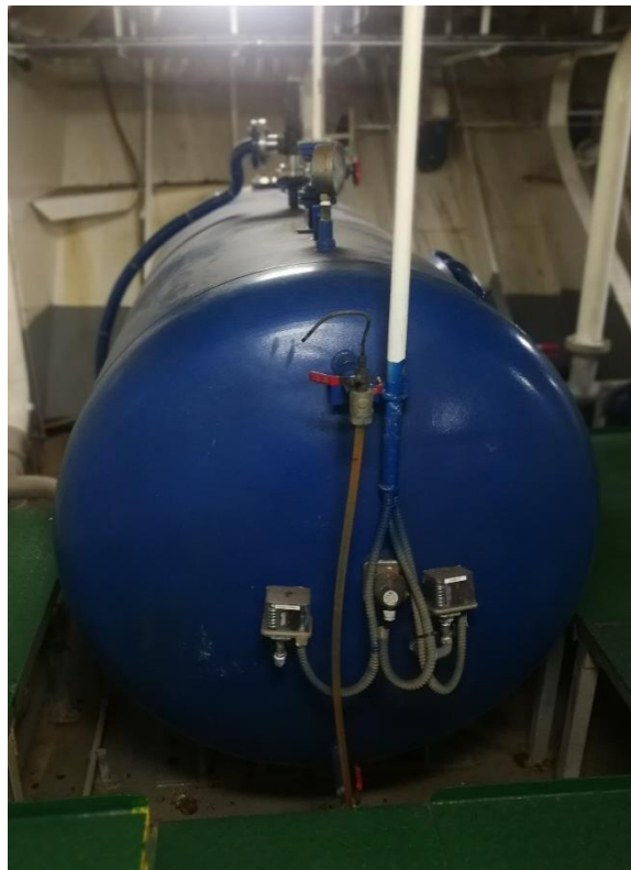
Ilustración 38. Tanque de sprinkler. Fuente propia.
