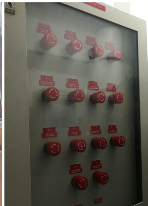
Ilustración 82. Paradas de emergencia de la ventilación de la máquina en el tronco de escaleras de la máquina. Fuente propia.
