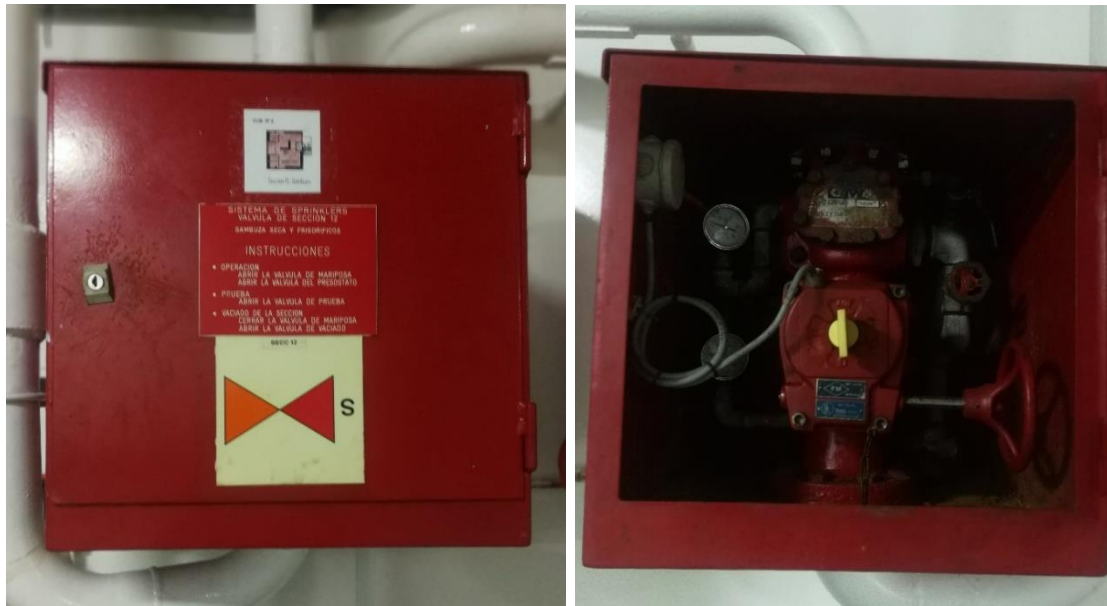
Ilustración 37. Cajas secciones de sprinkler. Fuente propia.
