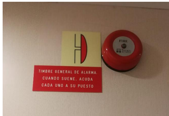
Ilustración 10. Timbre de alarma general de emergencia. Fuente propia.
