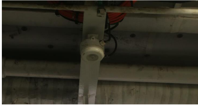
Ilustración 9. Detector de llama. Fuente propia.
