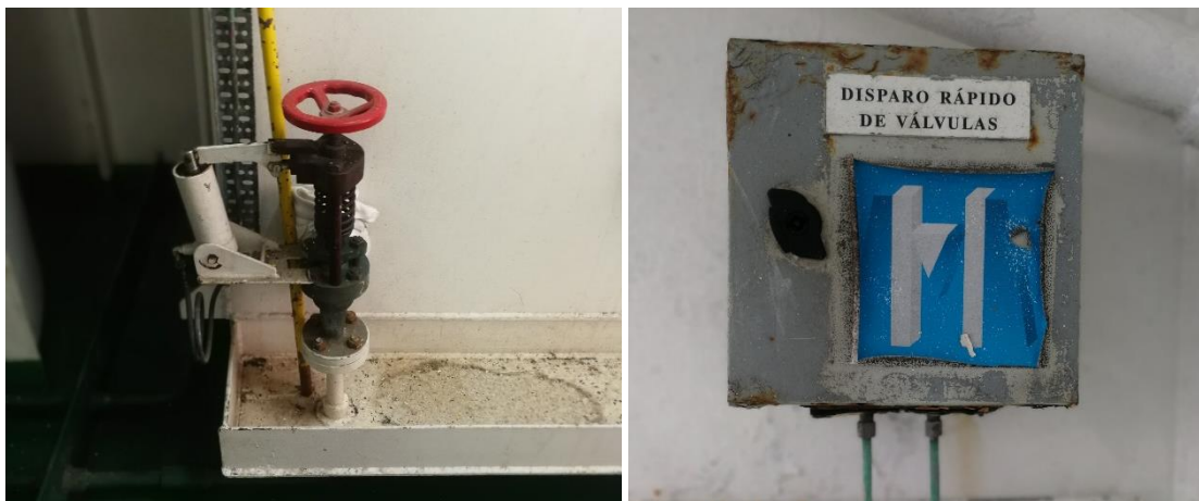
Ilustración 61. Válvula de disparo rápido de combustible. Fuente propia.
