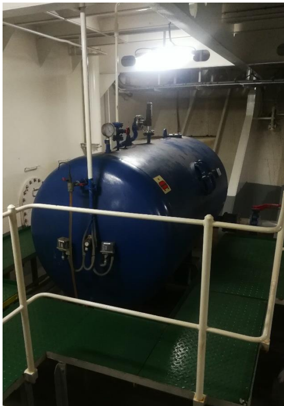
Ilustración 38. Tanque de sprinkler. Fuente propia.
