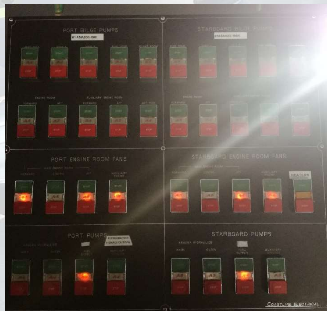
Foto: Panel control bombas hidráulicas y de sentina y ventiladores. Elaboración propia
