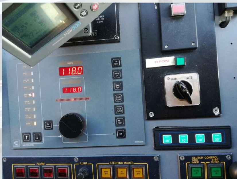
Foto: piloto automático. Elaboración propia
