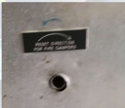
Foto: Rearme damper máquinas. Elaboración propia
