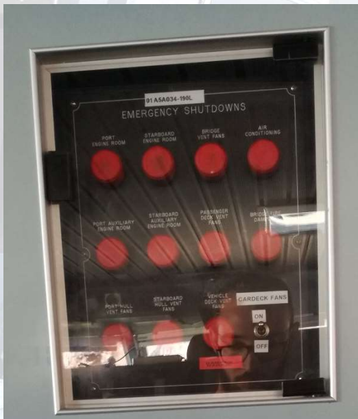
Foto: disparo dampers y apagado de ventilación
