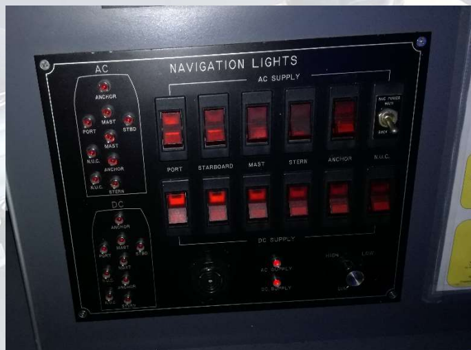
Foto: Panel luces navegación. Elaboración propia
