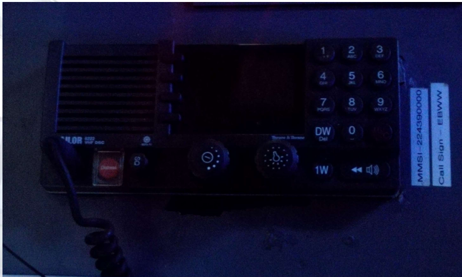
Foto: Radio VHF THRANE-THRANE Consola central. Elaboración propia
