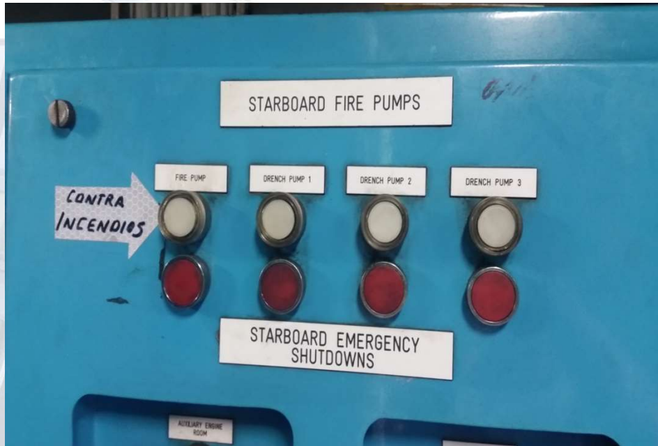
Foto: Override bombas C.I. Elaboración propia
