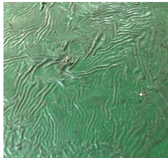
Ilustración 38: Arrugamiento. Fuente propia
