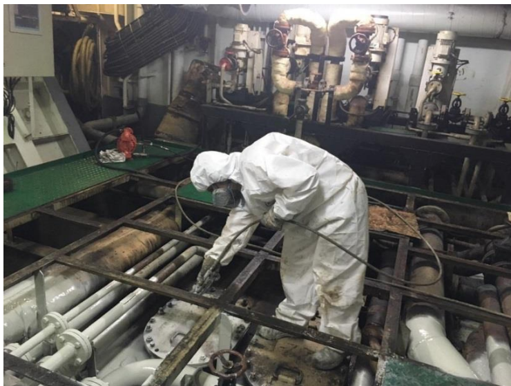
Ilustración 23: Epis en operación de pintado, buzo y mascarilla. Fuente propia
