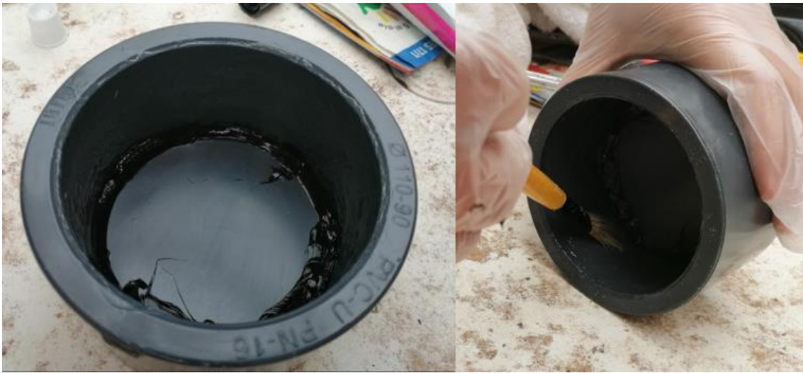
Figura 4.3. Aplicación de silicona en la izquierda y pegamento para PVC en la derecha
