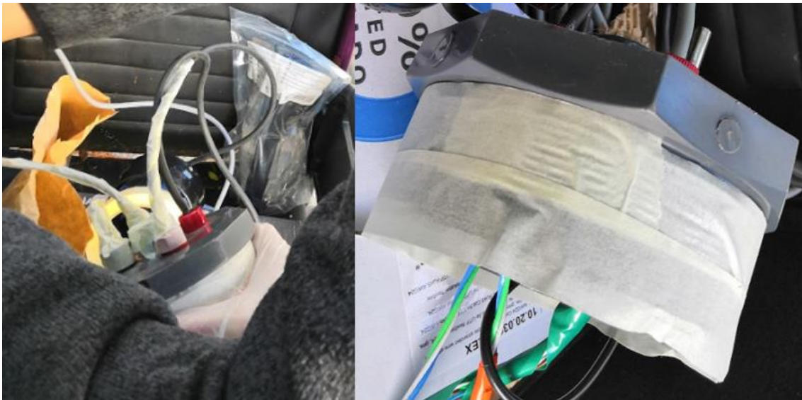
Figura 4.15. Protección de los elementos que no se van a pintar
