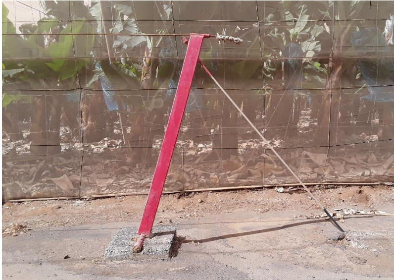
Figura 14: Estructura para tensar el cable en los tramos finales (Fuente: Propia)
