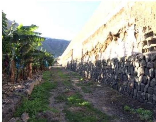
Figura 3: Caminos secundarios (Fuente: Caminos secundarios)
