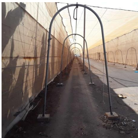
Figura 23: Distribución de torres y zapatas (Fuente: Propia)
