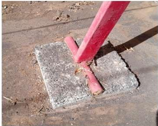
Figura 27: Detalle de pie de soporte del cable (Fuente: Propia)
