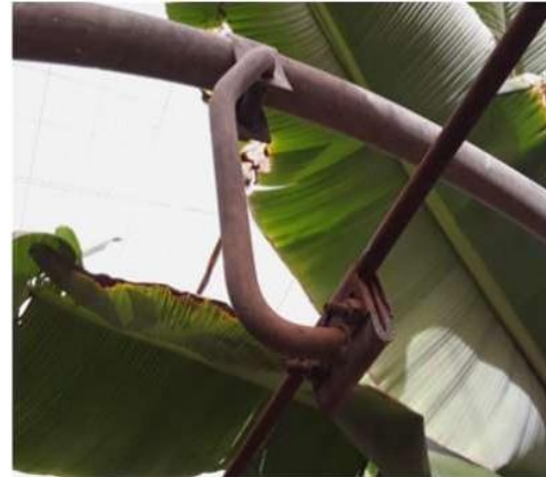
Figura 20: Sujeción del cable a la torre por medio de la pieza zeta y la charnela (Fuente: Propia)
