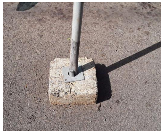
Figura 24: Detalle de zapatas (Fuente propia)
