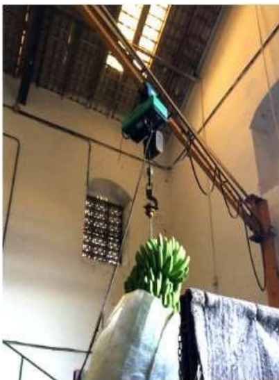
Figura 11: Operación de descarga de racimos con el apoyo de un polipasto (Fuente: Propia)
