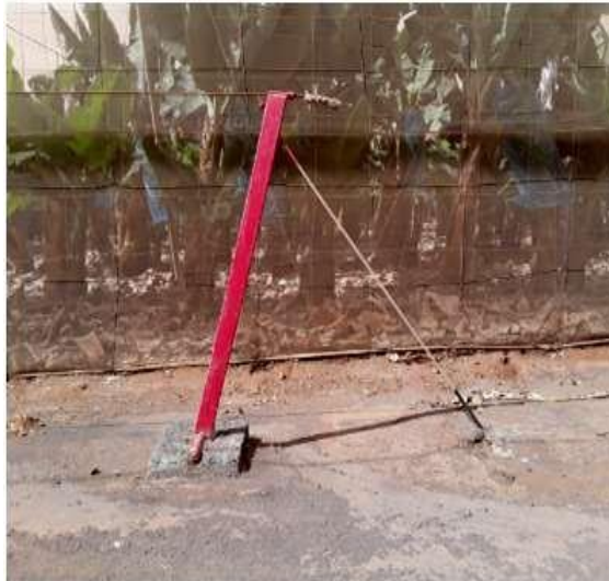
Figura 25: Soporte de extremos del cable (Fuente: Propia)
