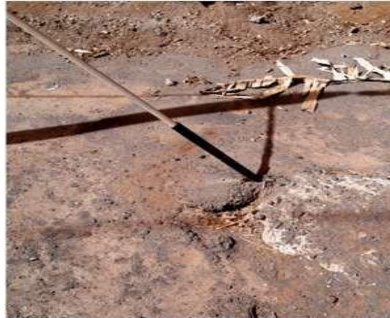
Figura 28: Sujeción de tensor al bloque de hormigón en el suelo (Fuente: Propia)
