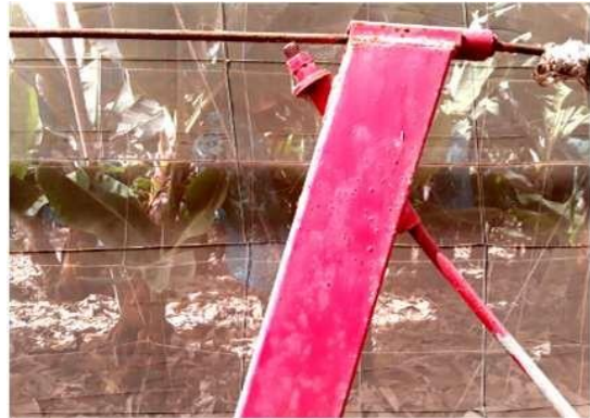
Figura 26: Detalle para tensar el cable y tirante de sujeción de soporte (Fuente: Propia)
