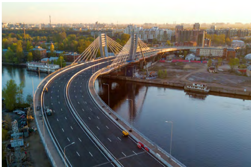
Figura 29. Fotografía del nuevo puente dedicado a A. Betancourt, mayo de 2018. Une las islas Petrovski, Serni y la de Dekabristov a través del Málaia Neva de San Petersburgo. Fuente: https://cdni.rbth.com/rbthmedia/images/2018.05/article/5af98f8615e9f94aac53f125.jpg .
