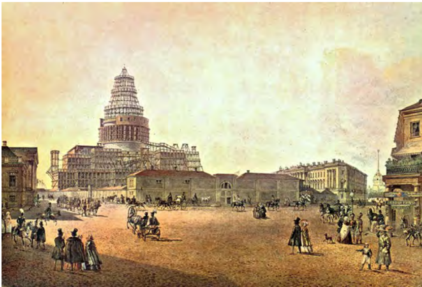
Figura 15. Construcción de la catedral de San Isaac (1818-1858). Acuarela antigua del siglo XIX. Fuente: http://www.san-petersburgo.com/sadovnik.htm .
