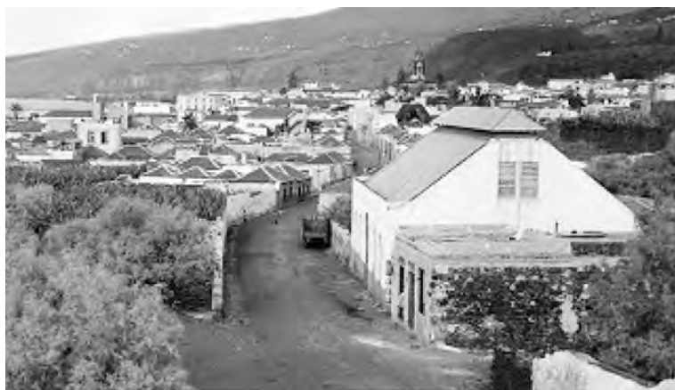
Foto 5. Ciudadela de El Chavito. Calle San Felipe, en la zona del Peñón del Fraile. El edificio de la ciudadela es el de la derecha de la imagen, con cubierta a dos aguas. Posiblemente, la fotografía fue tomada cuando aún era un centro de producción de energía eléctrica.
