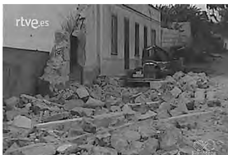
Fig. 12. Nodo 526 B (2 de febrero de 1953). Escombros resultantes de un temporal en Santa Cruz de Tenerife.
