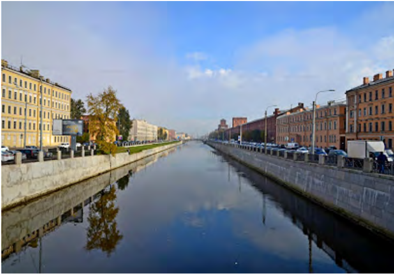
Figura 30. Canal Obvodny construido por A. Betancourt y De Wolant en 1816. De ocho kilómetros de longitud. Fuente: http://www.wikiwand.com/en/ .
