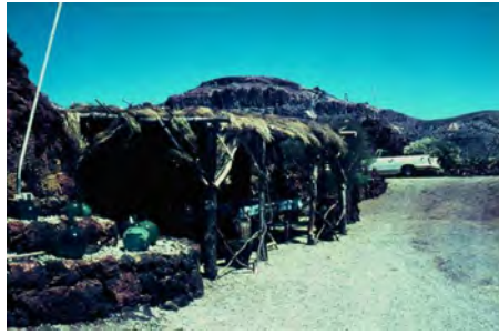
Fig. 19. Una construcción formada y techada con material vegetal. Al fondo La Cañada de La Grieta. Circa 1970.
