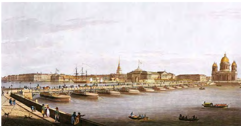
Figura 26. Puente de San Isaac sobre barcazas, de A. Betancourt, en 1820. Fuente: http://www.alamy.es/vista-del-puente-de-san-isaac-en-san-petersburgo-1824-colecc .
