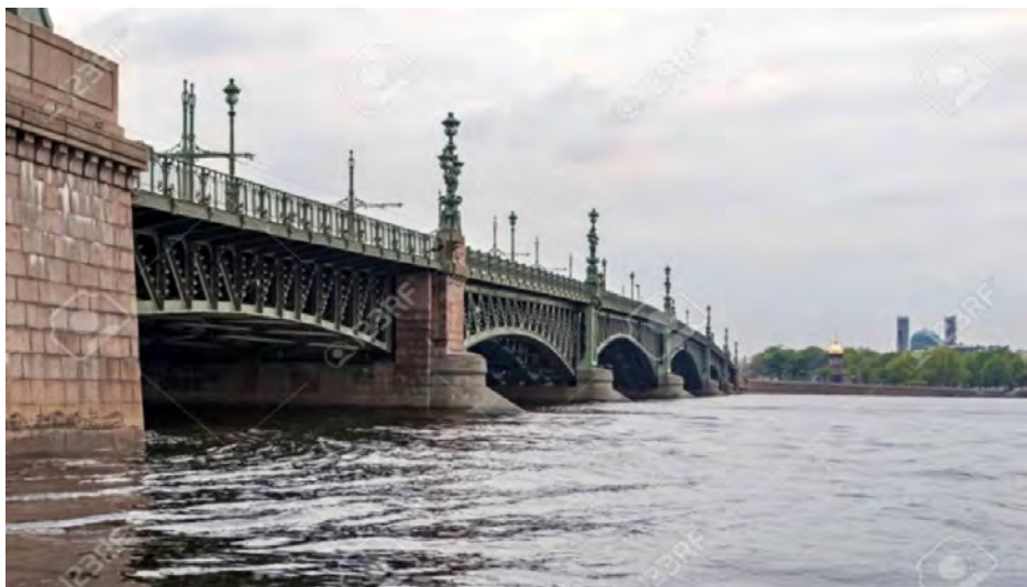
Figura 25. El puente actual Kamennyostroski, reconstruido en 1954.
