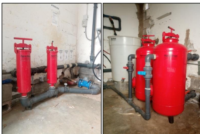
Foto 32 y 33: Filtros de malla (izquierda) y filtros de arena (derecha) del sistema de riego.
