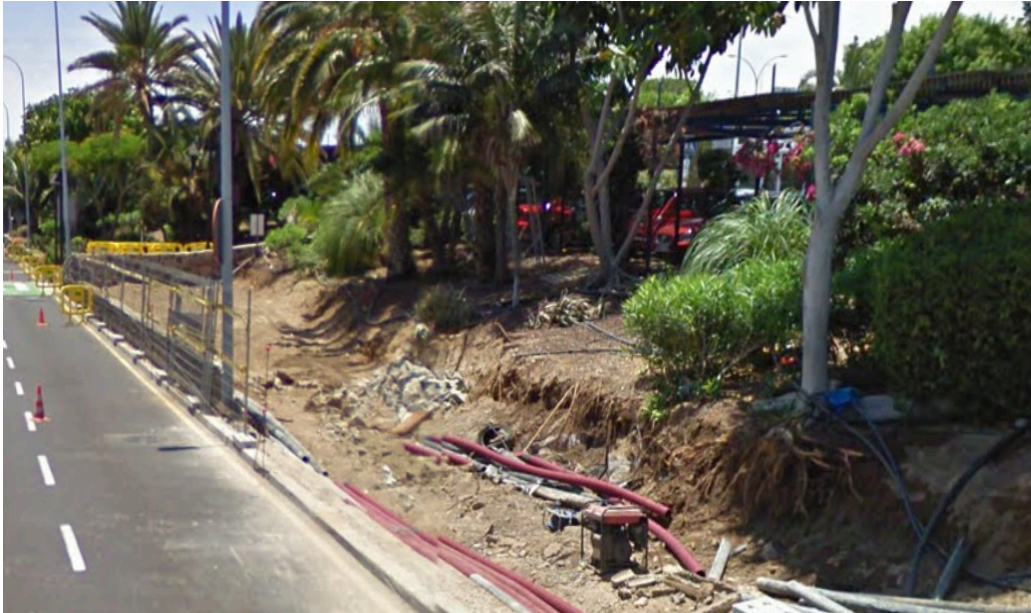
Ilustración 9: Obras de canalización. Fuente: GRAFCAN.
