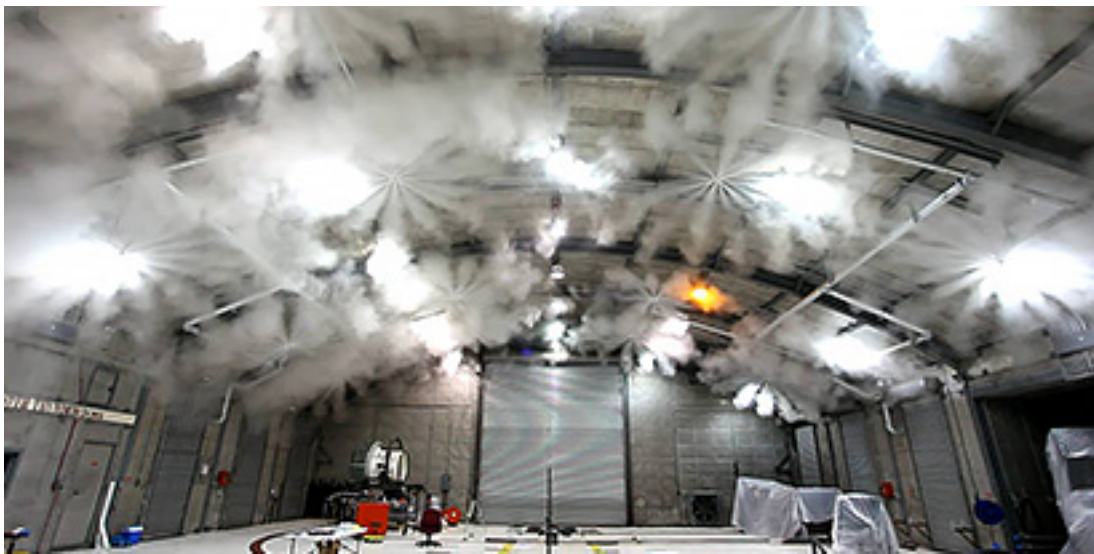
Figura 18: Botellas de extinción de gas Novec 1230
