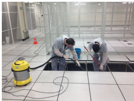
Figura 45: Limpieza técnica en sala CPD.
