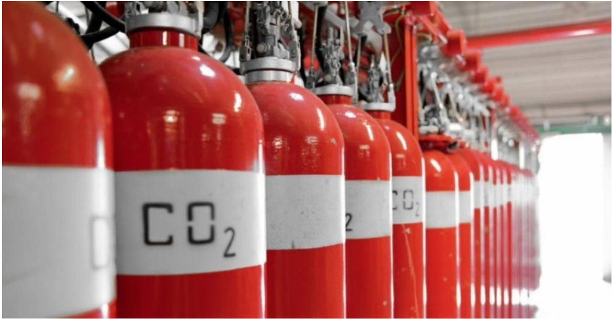
Figura 19: Botellas extintoras de gas CO_2
