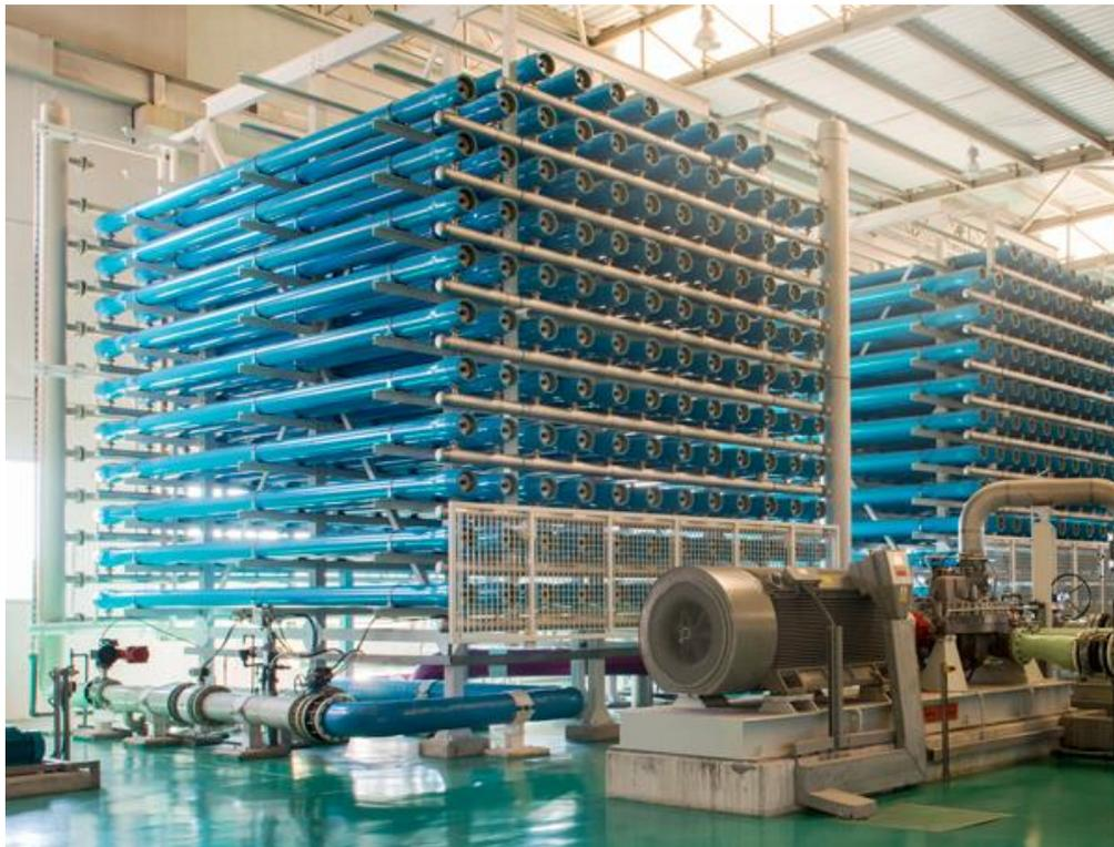
*Figura 31. Ejemplo bastidor de membranas EDAM Alicante. Fuente: Inima.es*
