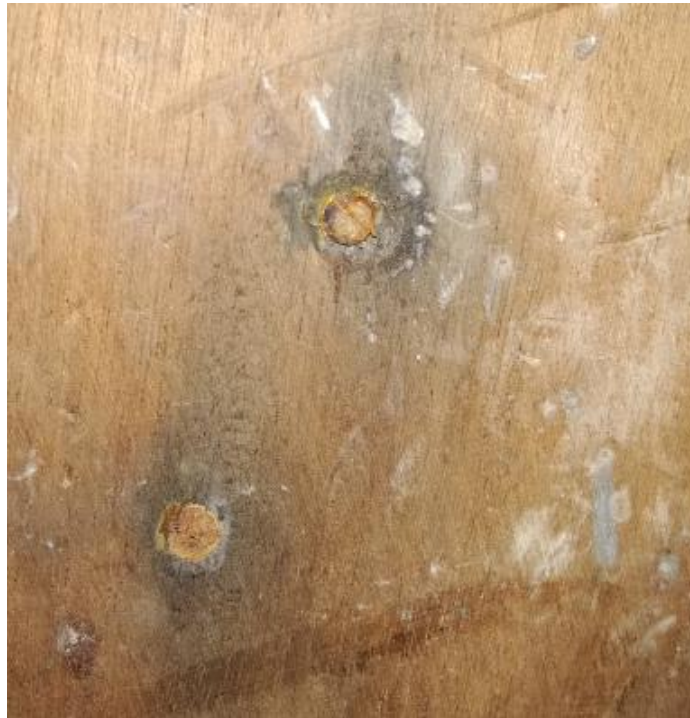
Figura 247. Unión del pie derecho al pedestal mediante tornillos. Vista inferior del pedestal.
