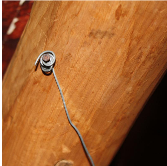
Figura 318. Detalle del alambre y el clavo al que se sujeta.
