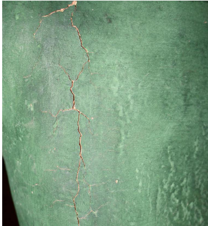
Figura 306. Grieta longitudinal.
