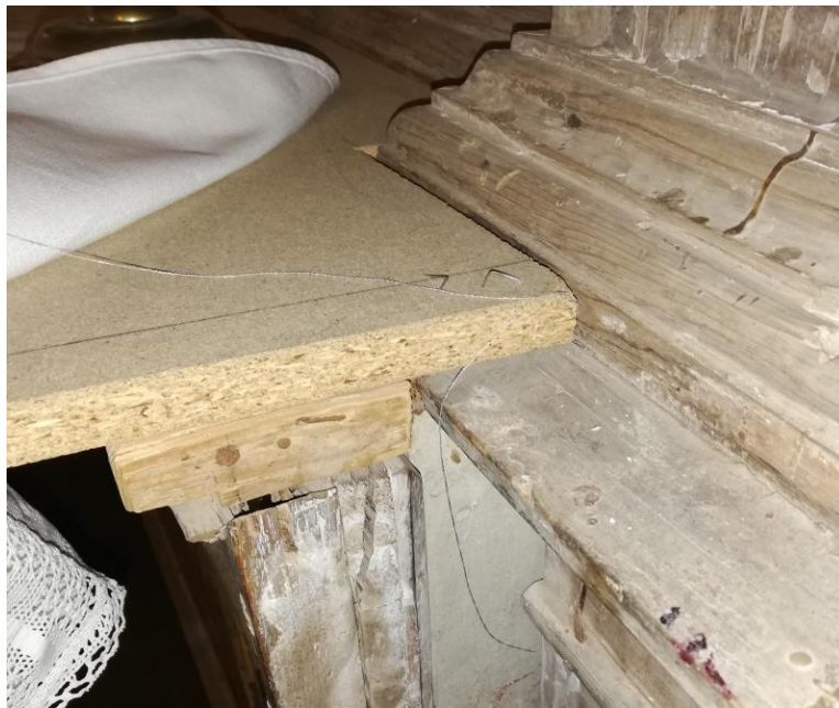
Figura 285. Intervención en el sotabanco tras el rebaje sufrido.
