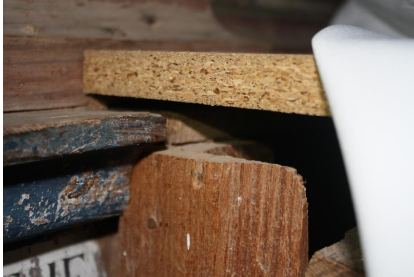
Figura 278. Intervención en el sotabanco, aplicación de conglomerado en la mesa del altar. Tablas originales partidas.
