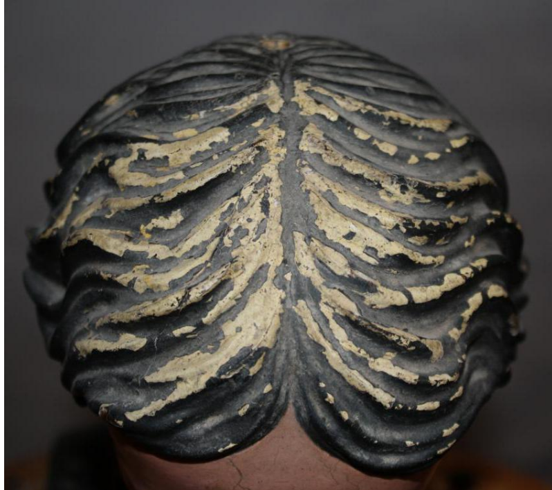
Figura 324. Pérdida polícroma debido a la constante presencia de escorrentías.
