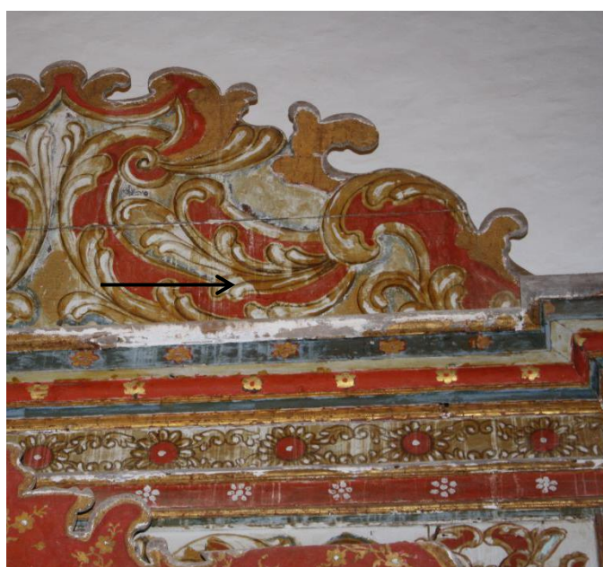
Figura 269. Detalle del recorrido de la escorrentía en la parte de la coronación y entablamento.
