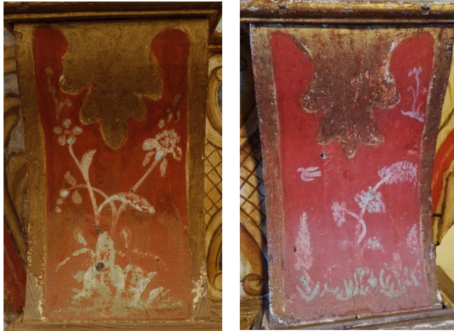
Figuras 66 y 67. Detalle de la ornamentación vegetal de los extremos de las molduras extremas del retablo, lado del evangelio y de la epístola, respectivamente.
