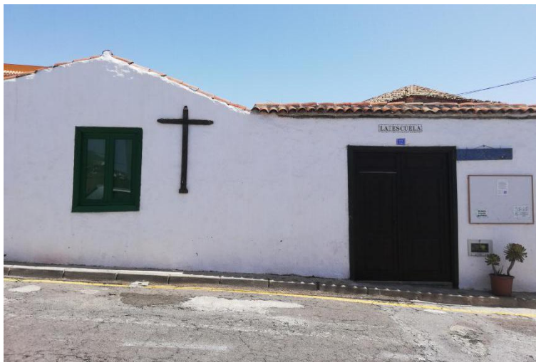
Figura 6. La antigua escuela de la Villa de Arico.
