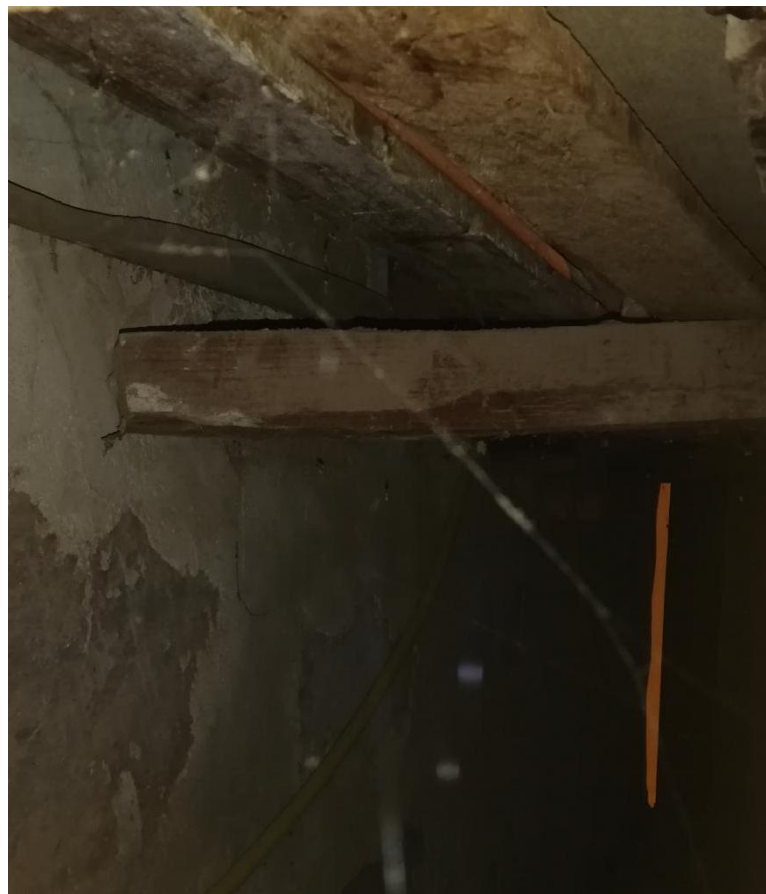
Figura 63. Viga anclada al muro que sostiene el reverso de la mesa del altar. Retablo del Nazareno.
