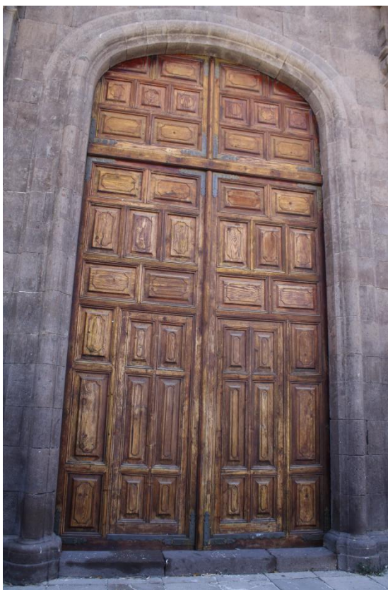
Figura 23. Detalle de la puerta principal de medio punto.
