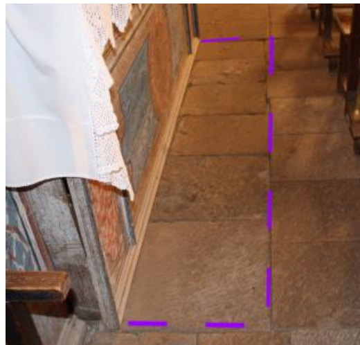
Figura 279. Antigua disposición del sotabanco. Marcas en el pavimento.
