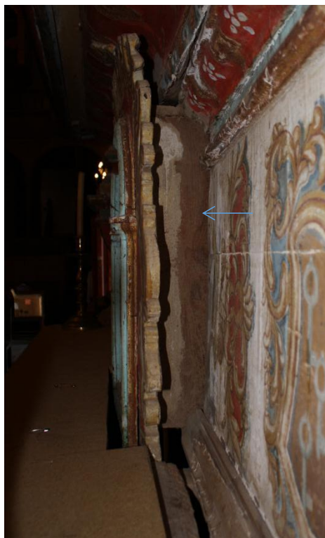
Figura 270. Desplazamiento del pequeño nicho del banco.
