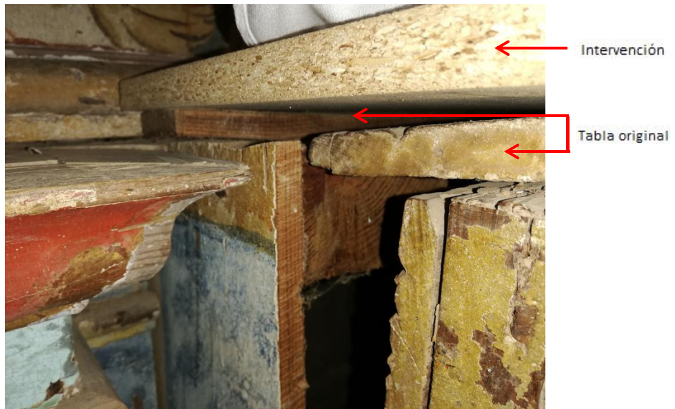
Figura 135. Detalle de la mesa del sotabanco intervenida.
