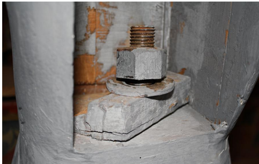
Figura 295. Detalle de la colocación del tornillo en el interior del torso.
