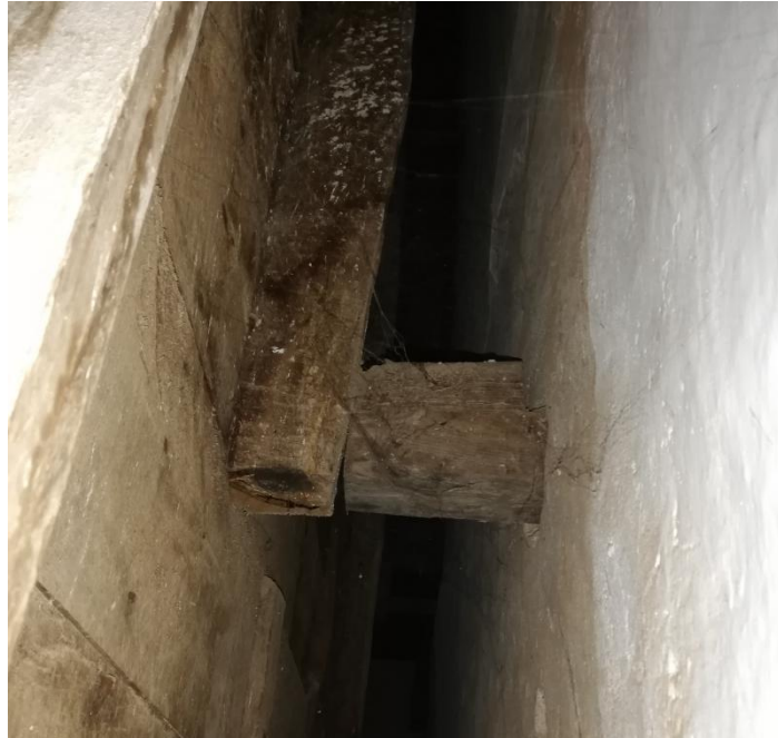
Figura 60. Riostras ancladas al muro. Varillas traseras para la unión de las piezas del reverso. Retablo de la Misericordia.
