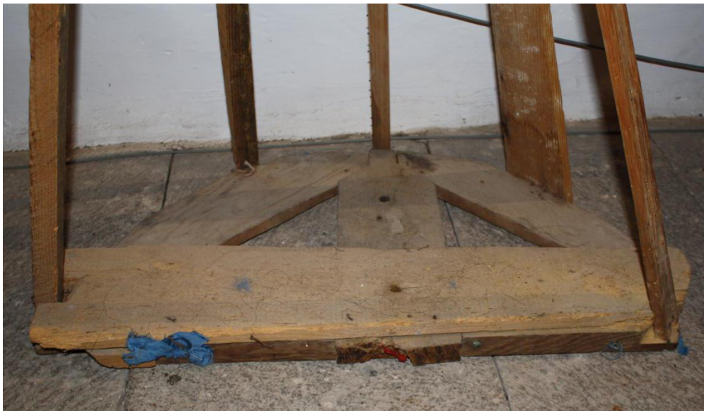
Figura 319. Alteración en la parte inferior de la estructura de candelero.
