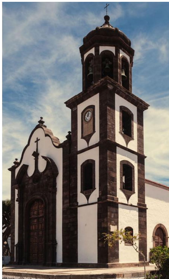
Figura 13. Torre de la parroquia.
