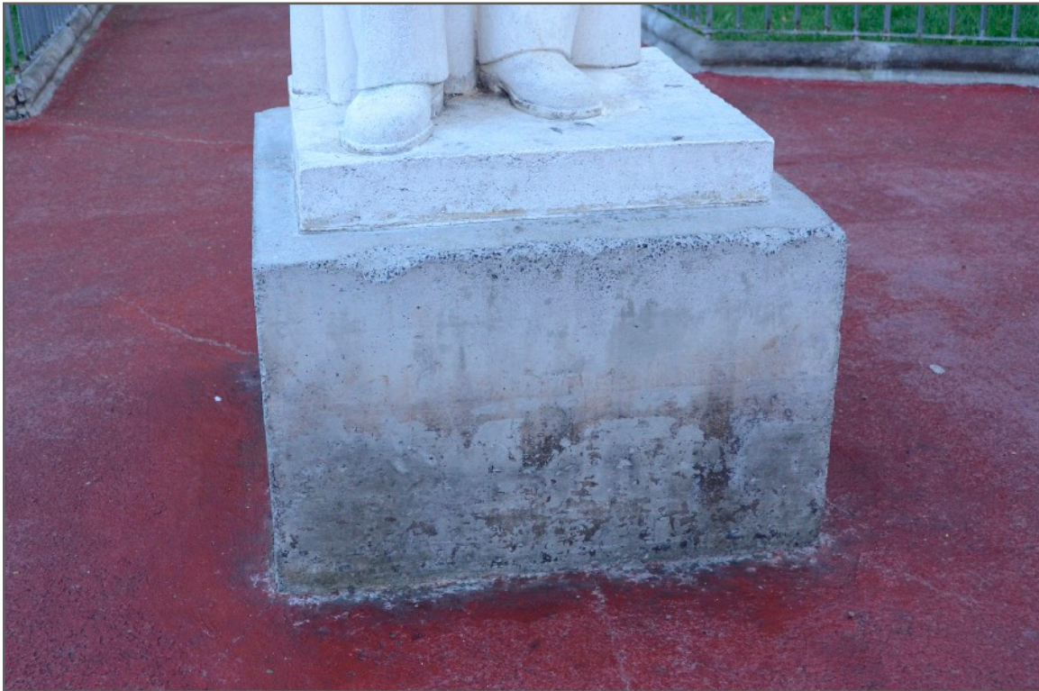
Fig. 17. Base de hormigón a modo de soporte de la obra
