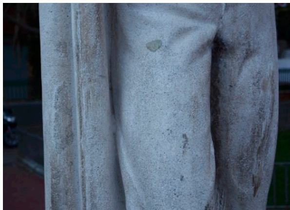
Fig. 36 y 37. Zonas donde se debe realizar la limpieza mecánica
