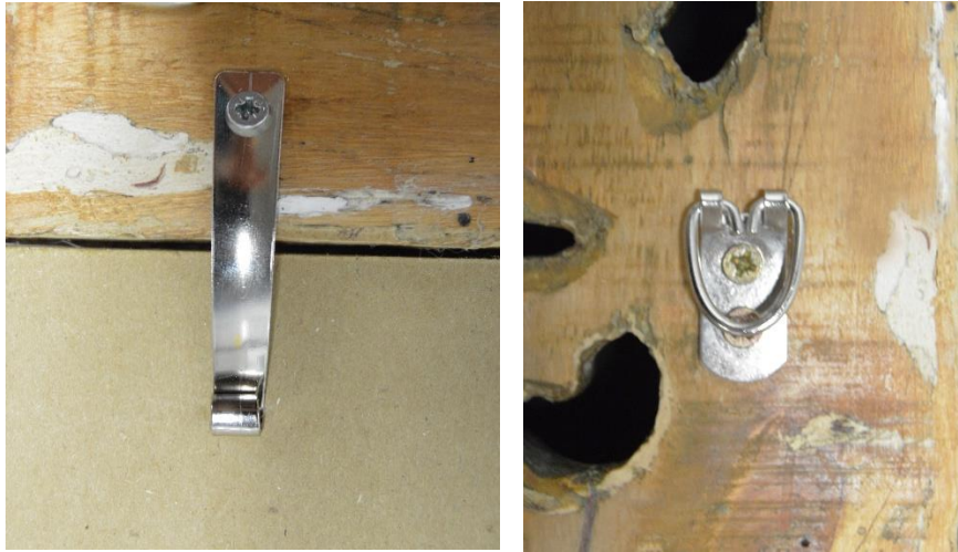
Figuras 288 y 289: Sistemas de sujeción del espejo y protección trasera y del colgado del marco.
