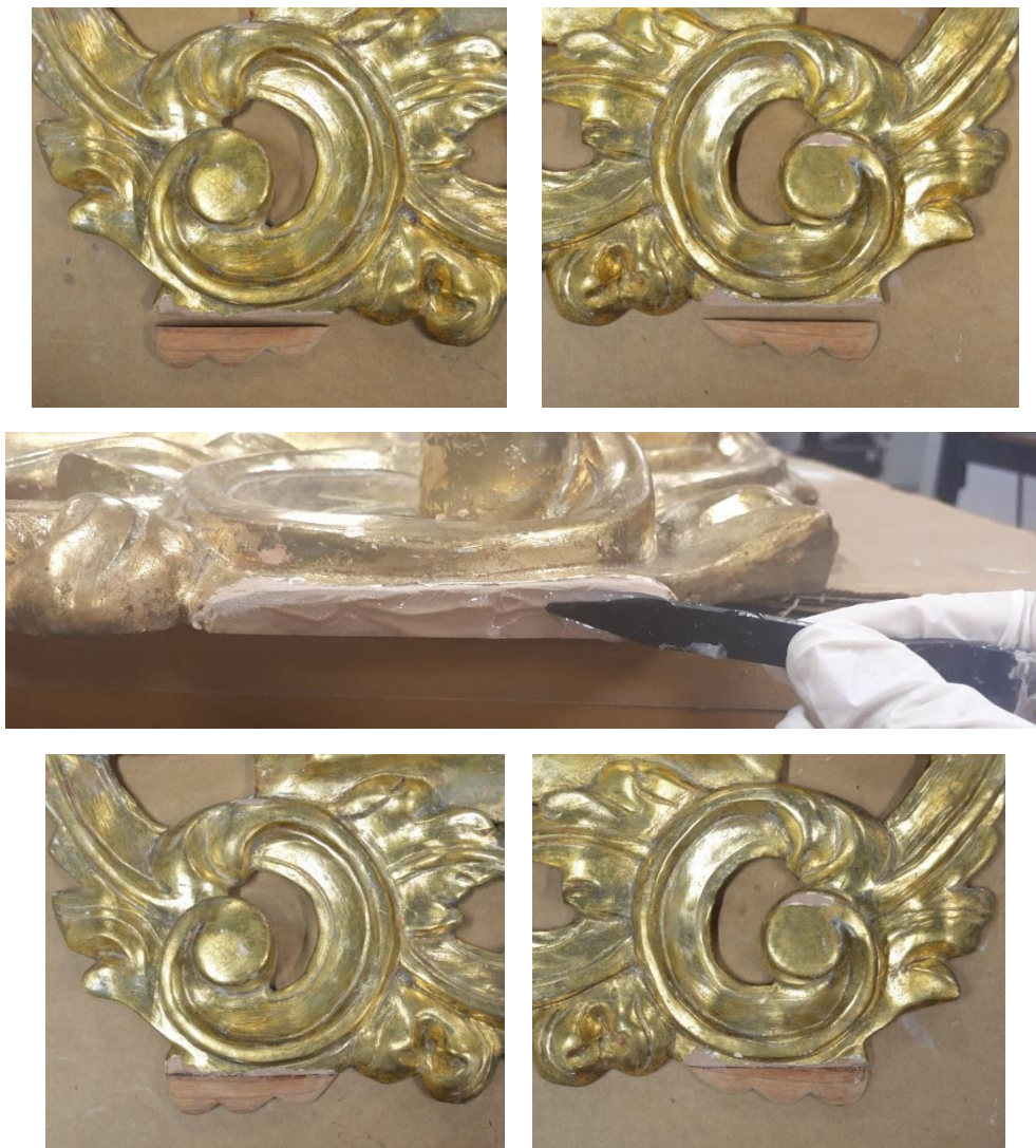
Figuras 206-210: Colocación de las piezas talladas.
