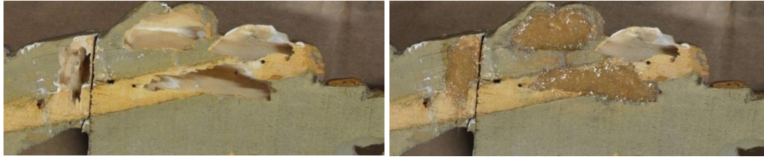
Figuras 139-140: Proceso de aplicación de la resina epoxi mezclada con el serrín claro de grosor medio.
