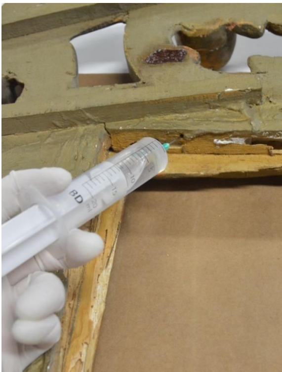
Figuras 116 y 117: Inyección e impregnación con brocha de la madera afectada
