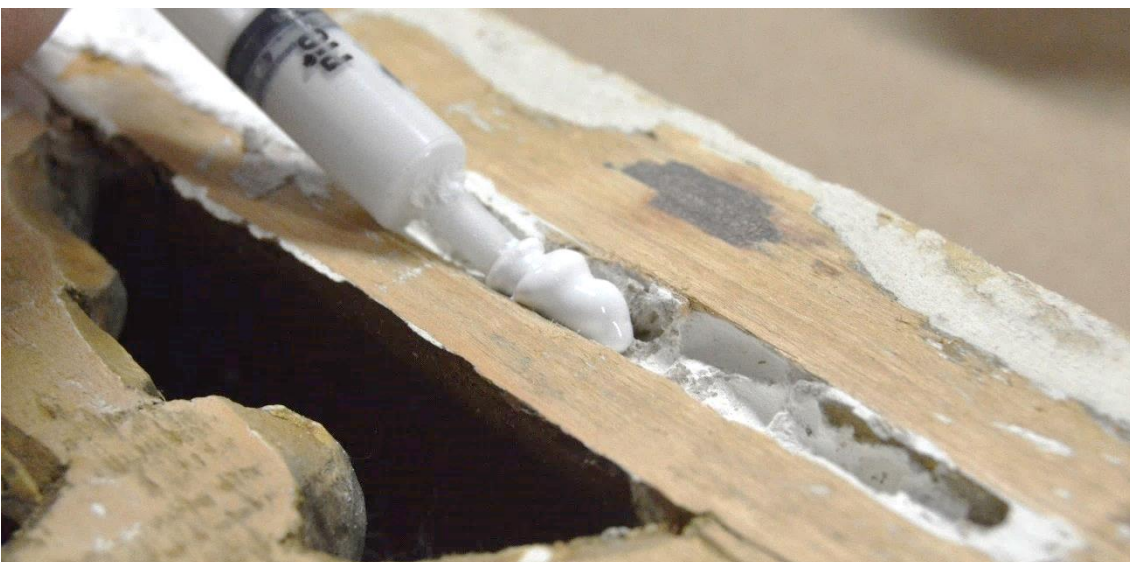
Figuras 153-155: Aplicación del alginato para rematar y reforzar las zonas intervenidas con yeso anteriormente, dependiendo de lo que requiera cada laguna se puede aplicar con espátula, jeringuilla e incluso pincel.
