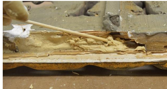
Figura 150: Aplicación de la pasta con ayuda de hisopo de madera.
