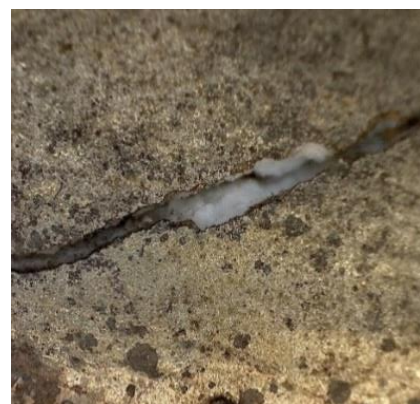
Figura 56: Imagen microscópica de grieta en la cara anterior del marco. Afecta al dorado y la preparación.
