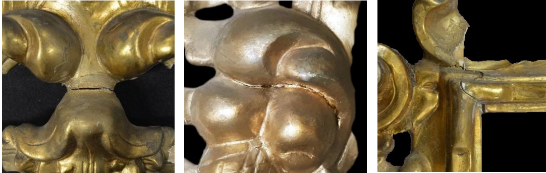
Figuras 57-59: En estas imágenes podemos apreciar algunos ejemplos de las grietas que afectaban al marco, concretamente vistas desde su parte delantera.
