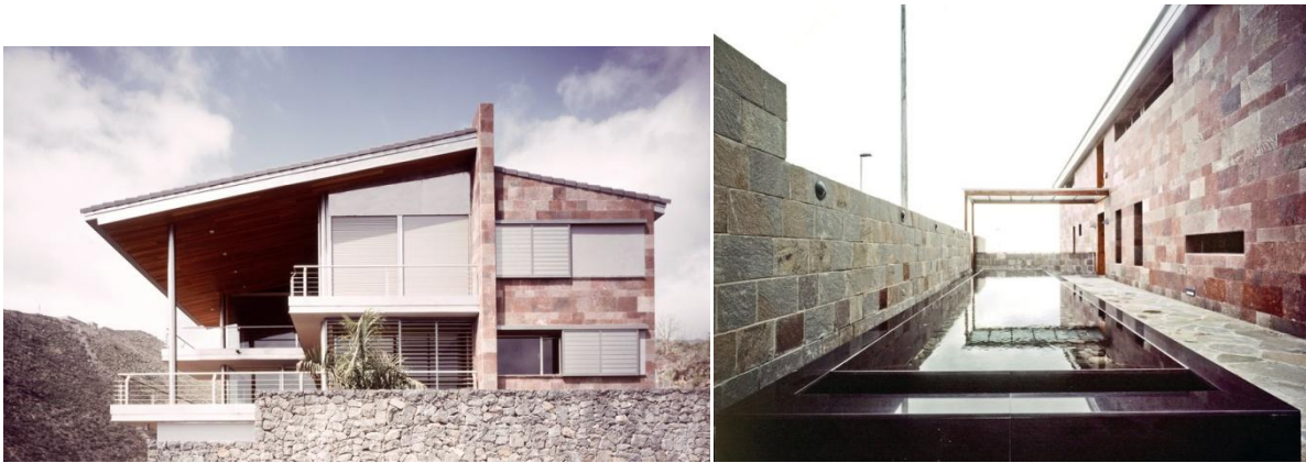
Figuras 36 y 37.. Chalet Unifamiliar. Residencial Anaga. Correa + Estévez Arquitectura. Santa Cruz de Tenerife. 1992. Correa + Estévez Arquitectura.
