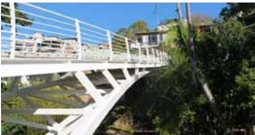
Figura 2. Pasarela sobre el río Cuale
