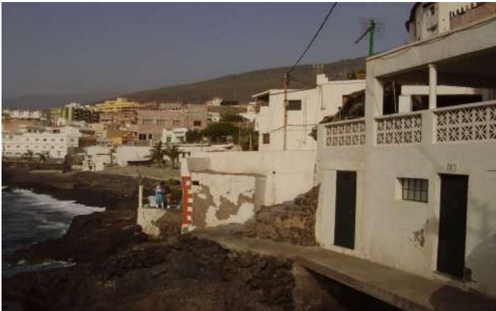
Foto 2. Imagen del pueblo de Cho Vito antes de llevar a cabo el proyecto de demolición de las viviendas, Candelaria, Tenerife
