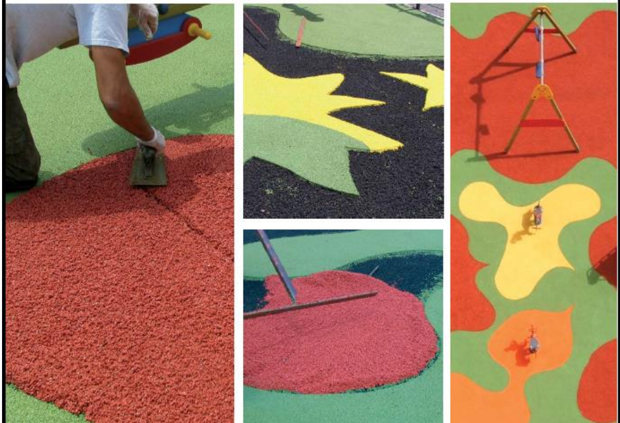
Figura 11.- Ejecución del pavimento “in situ”.
