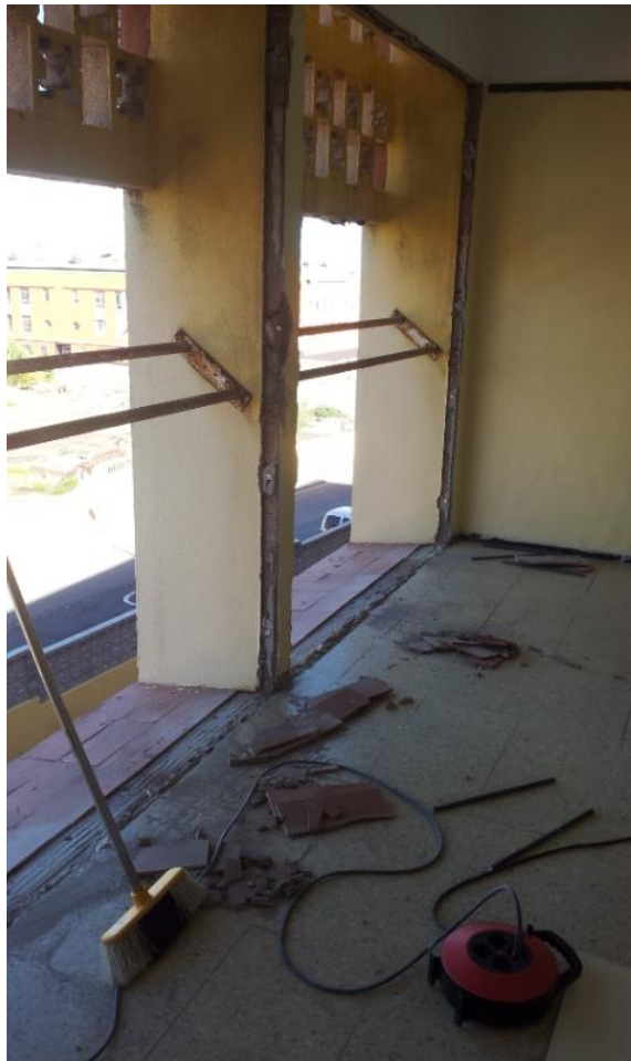
Barandillas que se eliminarán. Vista cuando se retiran las ventanas.
