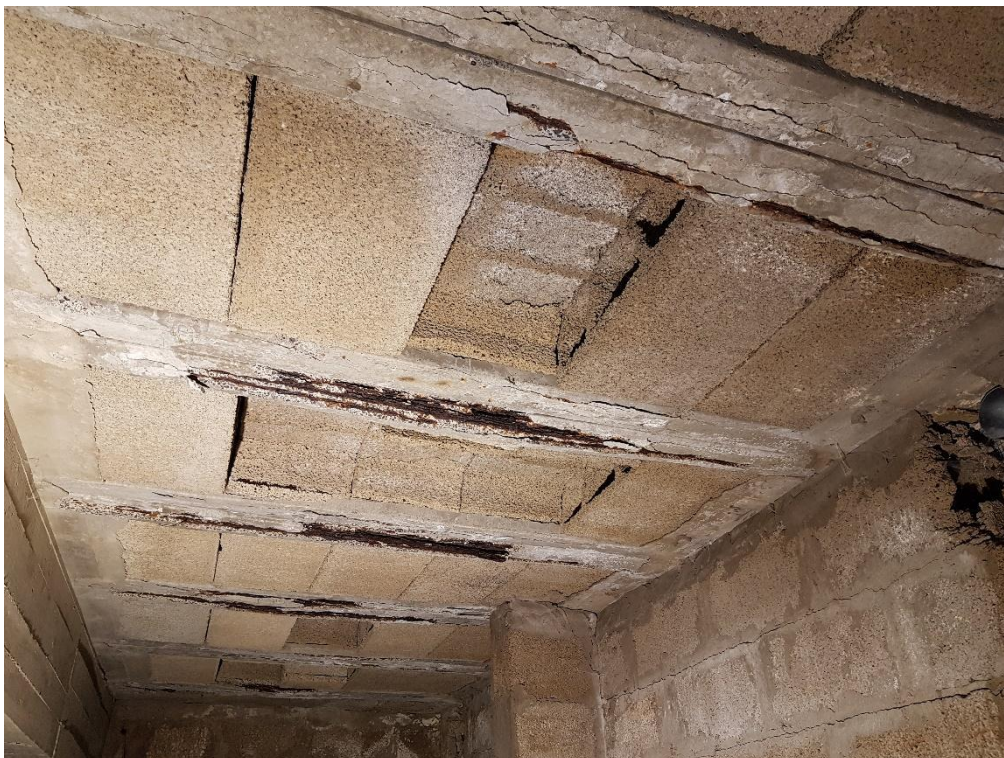
VISTA INFERIOR DEL PASILLO – VOLADIZO:
