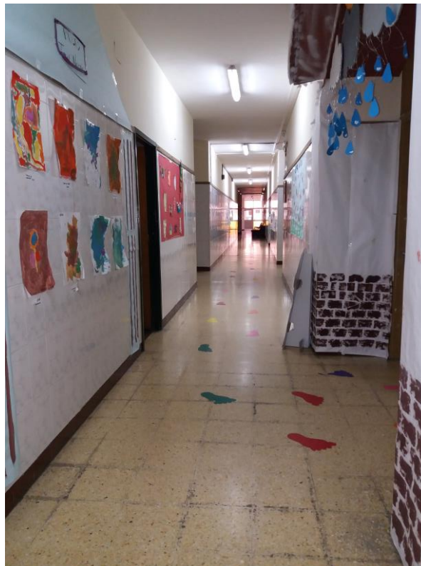
Imagen en la que se puede observar la antigüedad de las luminarias.
