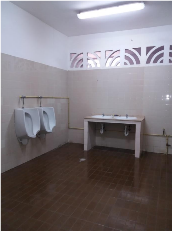
Instalación de fontanería superpuesta.
