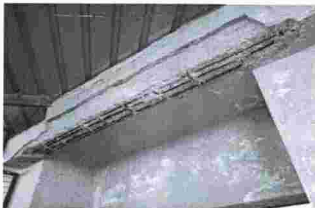
Zona desprendimiento baños.(picado)
