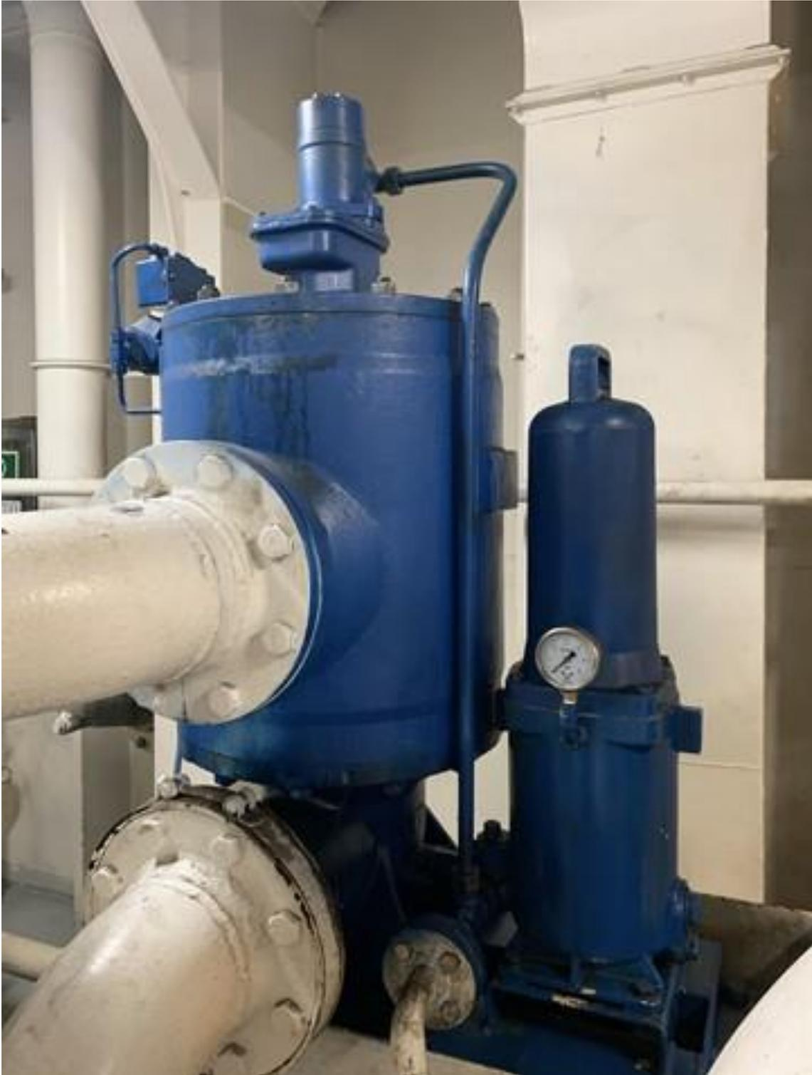
*Ilustración 36. Filtro automático de aceite. Fuente: Trabajo de campo.*
