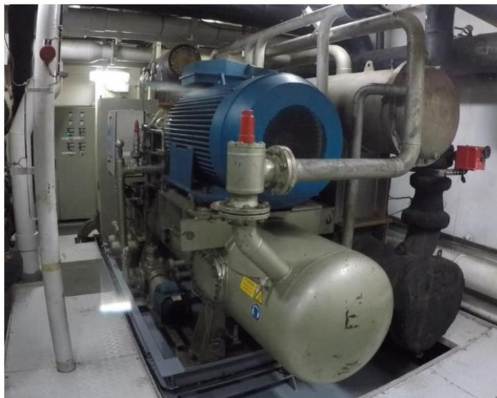
*Ilustración 26. Unidad compresores A.A.C.C. Fuente: Trabajo de campo.*
