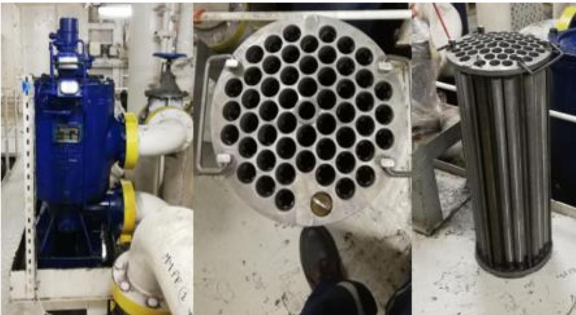
*Ilustración 10. Filtro automático de aceite. 1: aspecto exterior. 2 y 3: filtro compuesto por las velas. Fuente: Trabajo de campo.*
