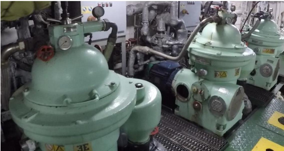
*Ilustración 20. Depuradora F.O. Fuente: Trabajo de campo.*
