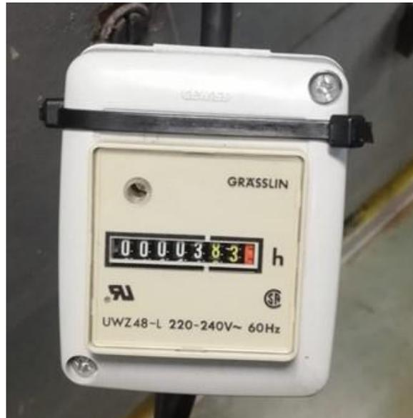
Ilustración 48. Contador de horas de funcionamiento de caldera. Fuente: Trabajo de campo.
