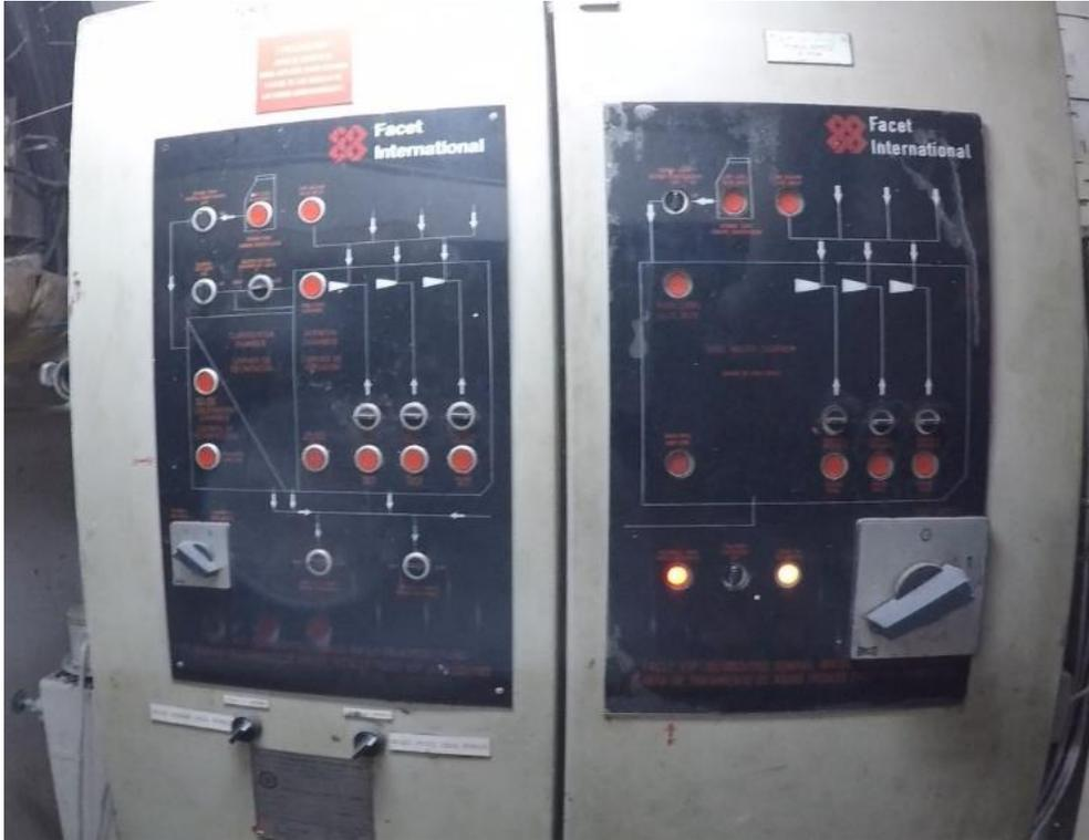
*Ilustración 24. Cuadro maniobra planta séptica. Fuente: Trabajo de campo.*
