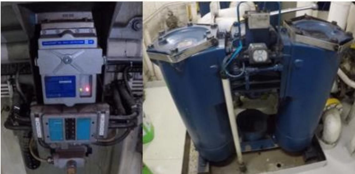
*Ilustración 11. Unidad de control Visatron y Filtro de mochila / Filtro Policía de aceite. Fuente: Trabajo de campo.*
