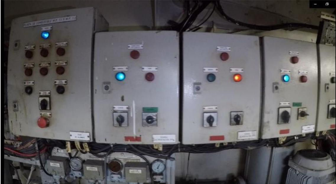
*Ilustración 28. Cuadro de averías del módulo y de las bombas. Fuente: Trabajo de campo.*
