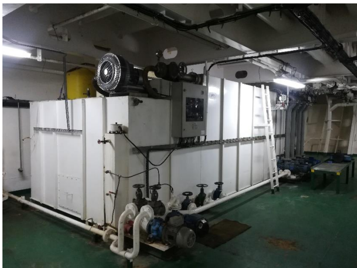
Ilustración 27 Planta séptica (elaboración propia) [ 7 ]
