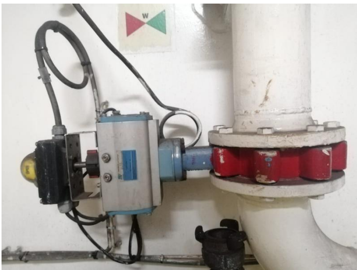
Ilustración 11 Válvula de mariposa (elaboración propia) [ 7 ]
